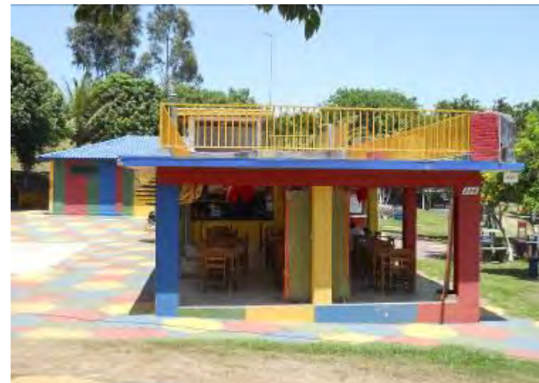
Foto 21: Construções do balneário, utilizando de uma tipologia bem colorida.
