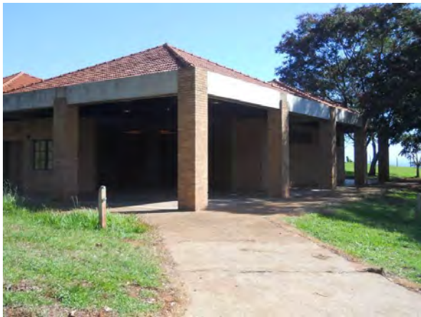
Foto 27: Edifício sem transição do interno e externo.
