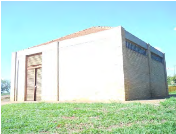
Foto 26: Edifício fechado em alvenaria aparente.
