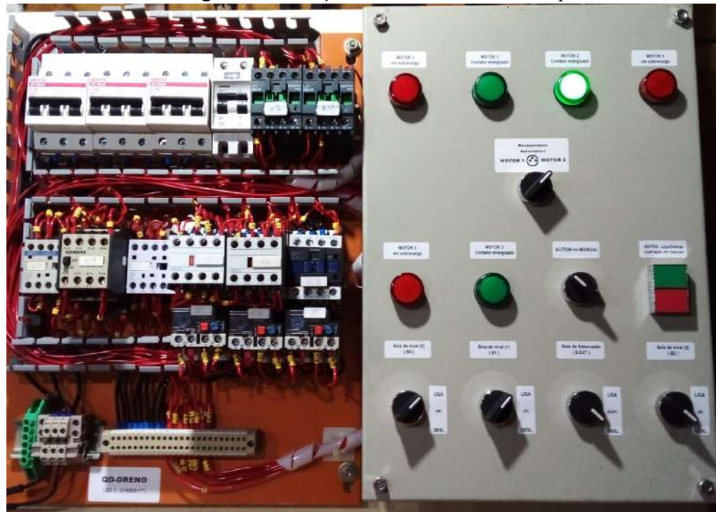
Figura 43: Seleção do modo bomba 2 no painel
