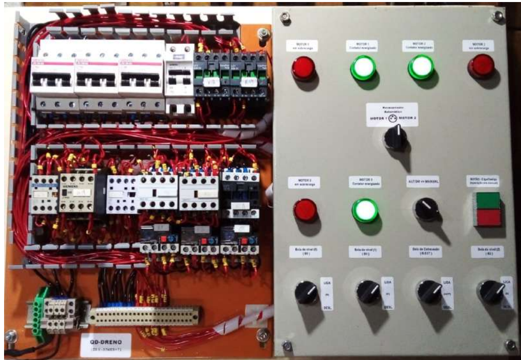
Figura 47: Ativação do motor 3 pela boia b2 no painel
