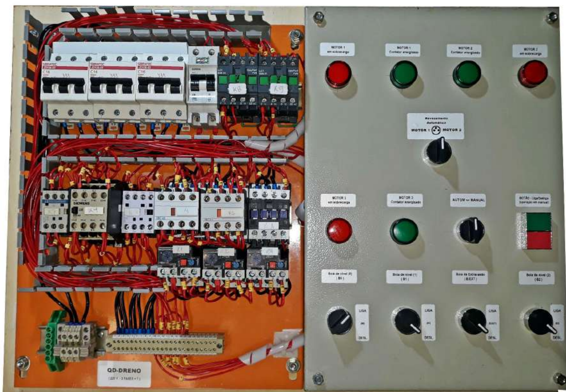
Figura 41: Montagem do sistema de comando e manobra
