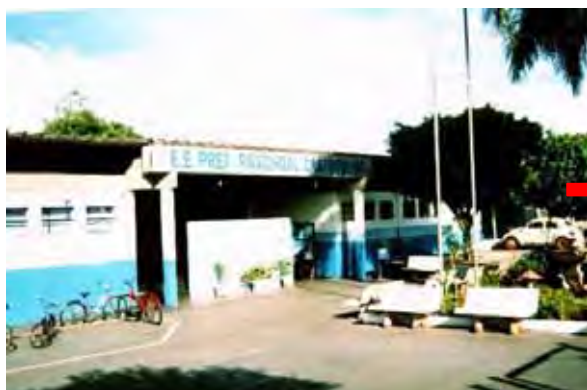
Foto 01: Fachada da Escola
