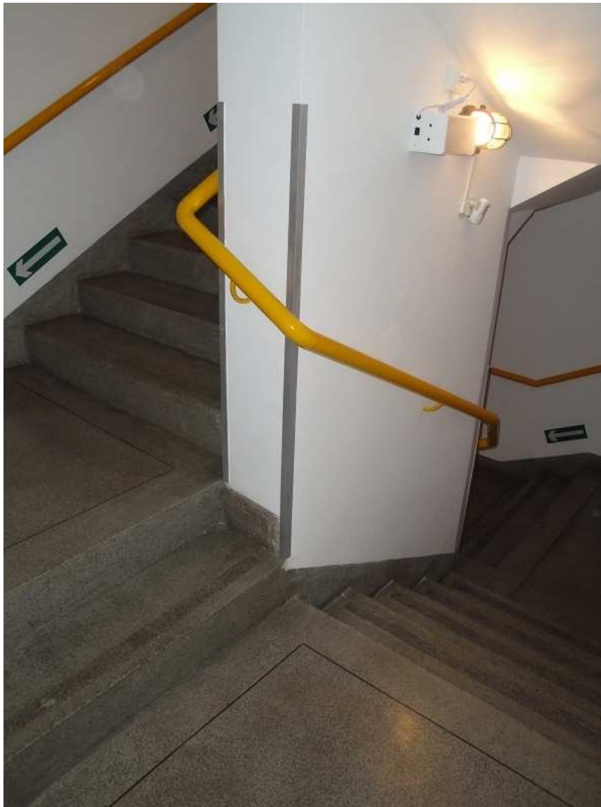
Figura 9. Escada do Hospital Estadual Bauru.
