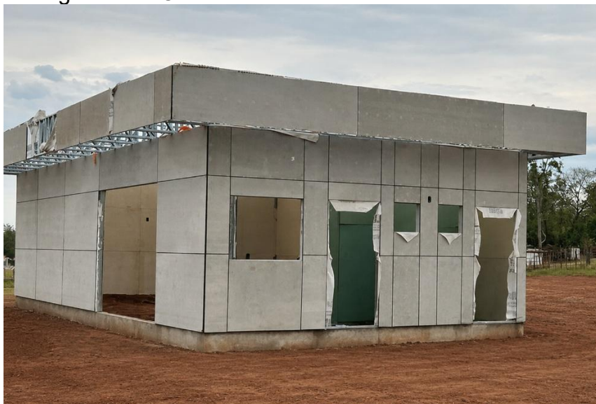
Figura 14 – Obra 4 Salão de festas executado em LSF
