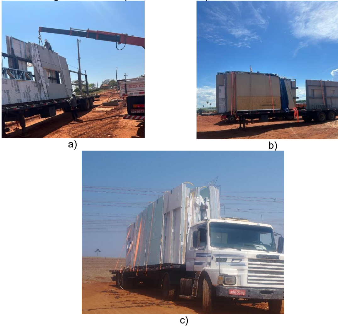
Figura 25 – Transporte dos Painéis pré-fabricados de LSF
