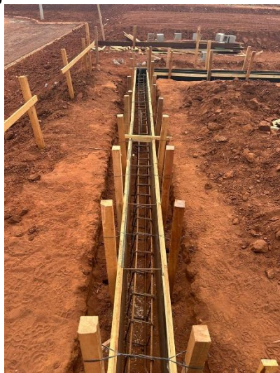
Figura 21 – Alinhamento e montagem das formas das vigas baldrames
