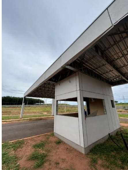
Figura 13 – Obra 3 Guarita executada em LSF
