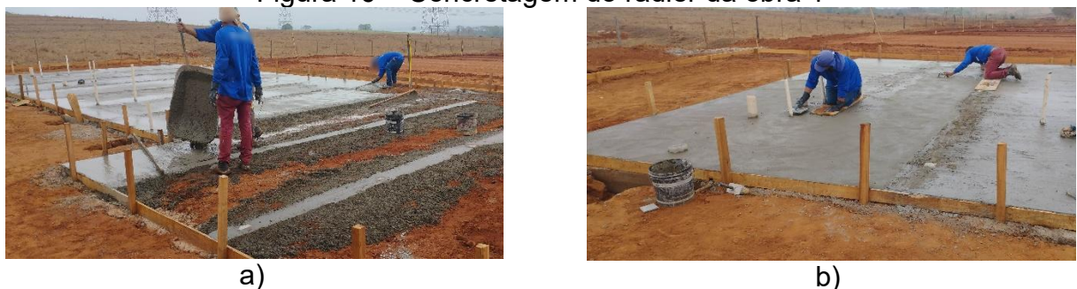
Figura 16 – Concretagem do radier da obra 1
