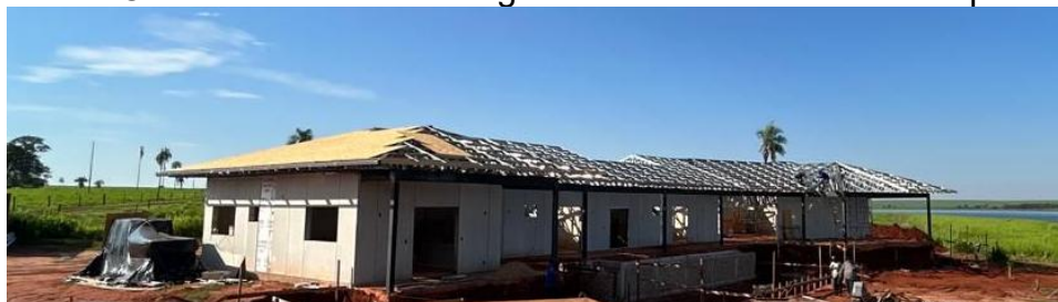
Figura 12 – Obra 2 executada em Light Steel Frame durante a etapa de cobertura
