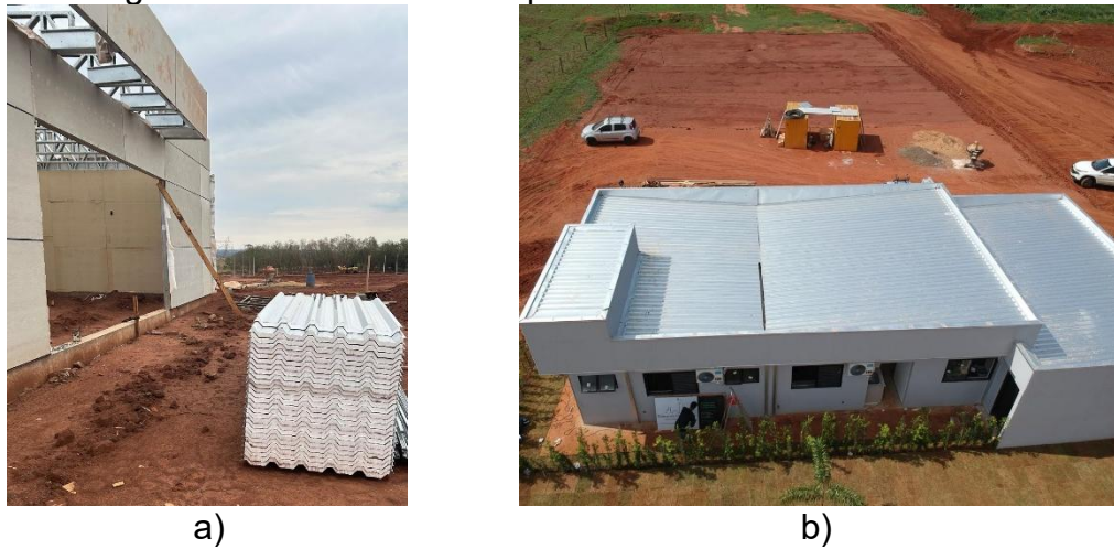
Figura 35 – Cobertura com platibanda no sistema LSF
