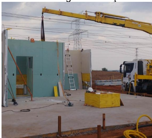
Figura 27 – Içamento e posicionamento dos painéis
