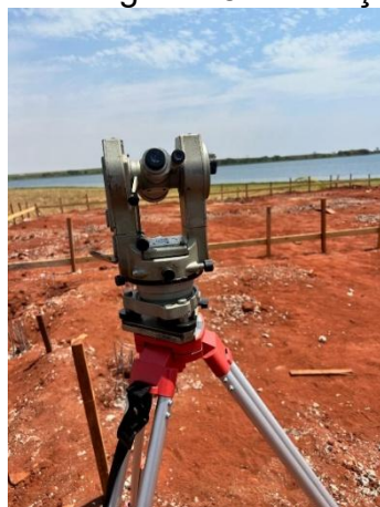
Figura 18 – Locação da fundação com o auxílio da topografia
