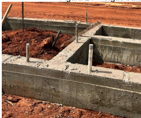
Figura 24 – Vigas baldrame finalizadas
