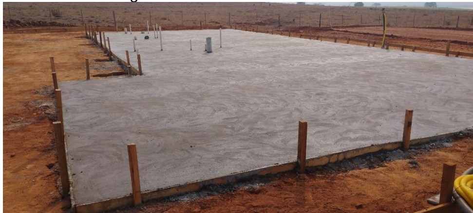
Figura 17 – Radier da obra 1 finalizado
