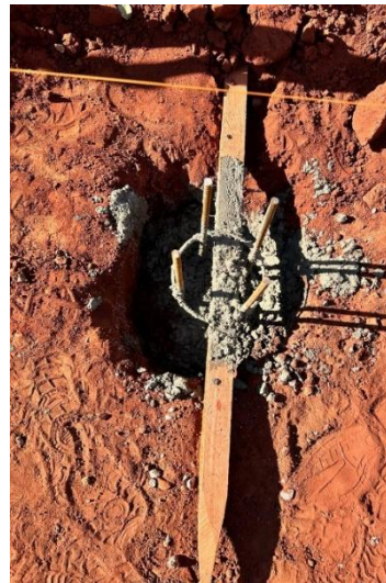
Figura 19 – Estacas moldadas in loco da obra 3
