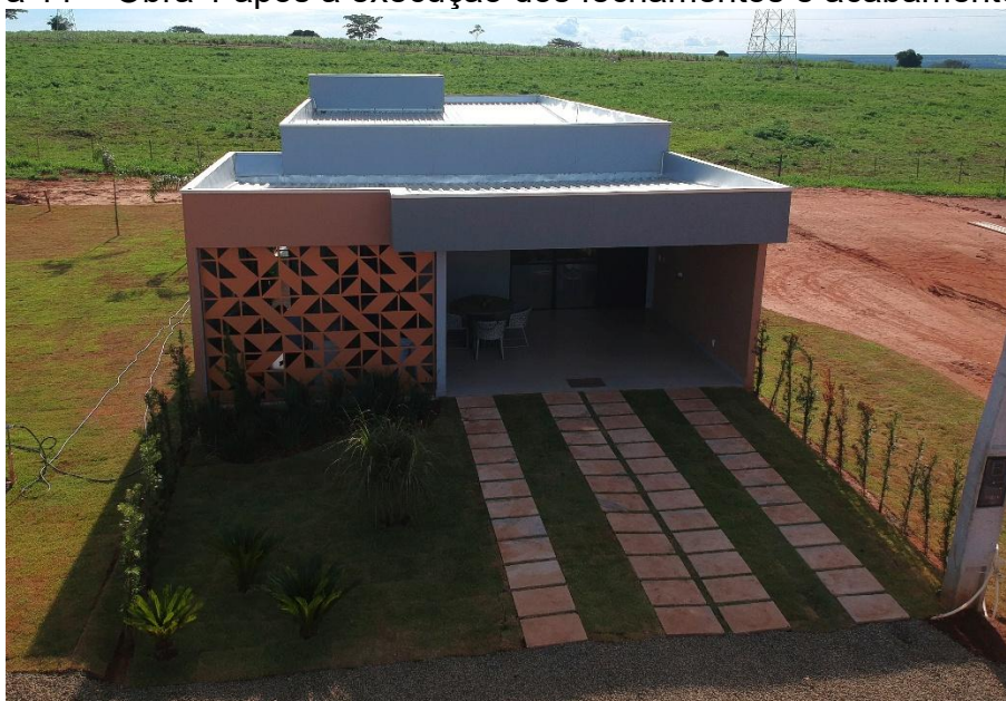
Figura 11 – Obra 1 após a execução dos fechamentos e acabamentos externos
