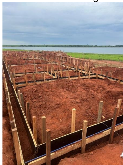
Figura 21 – Alinhamento e montagem das formas das vigas baldrames
