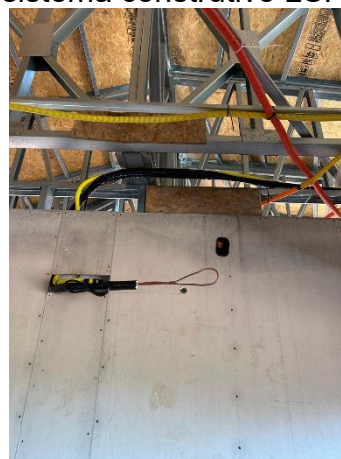
Figura 32 – Instalações elétricas no sistema construtivo LSF
