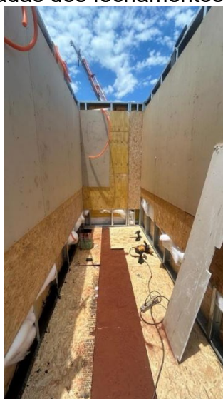
Figura 31 – Retiradas dos fechamentos para a fixação dos painéis
