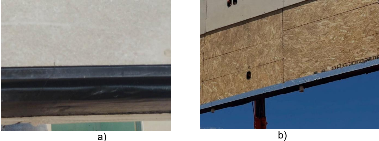
Figura 28 – Manta asfáltica adesiva na base dos painéis
