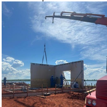
Figura 27 – Içamento e posicionamento dos painéis
