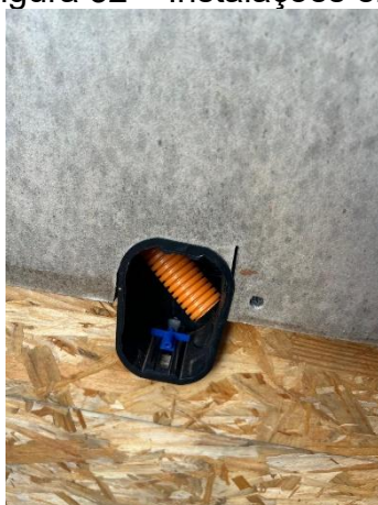
Figura 32 – Instalações elétricas no sistema construtivo LSF
