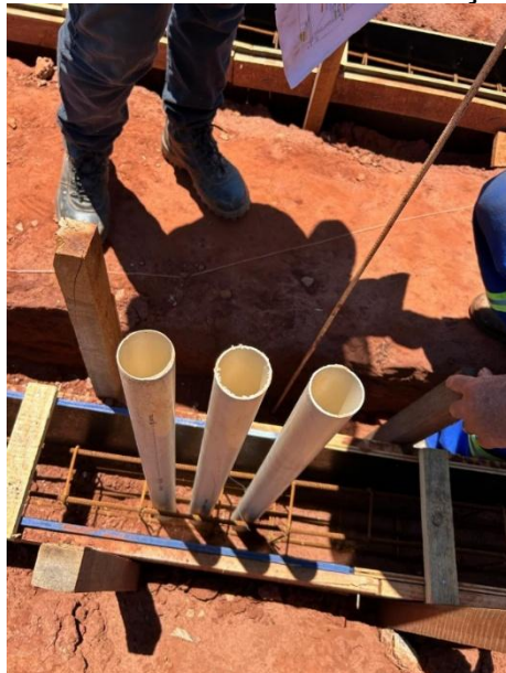
Figura 22 – Posicionamento das tubulações na viga baldrame
