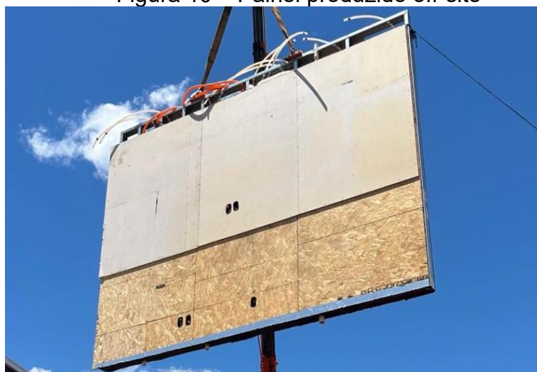
Figura 10 – Painel produzido off-site
