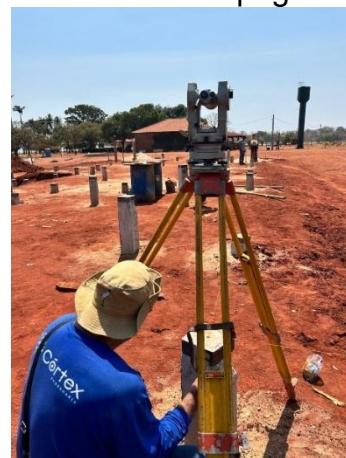
Figura 18 – Locação da fundação com o auxílio da topografia
