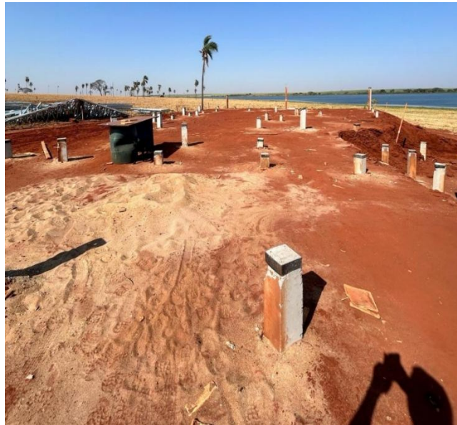
Figura 20 – Estacas pré-moldadas utilizadas na obra 2
