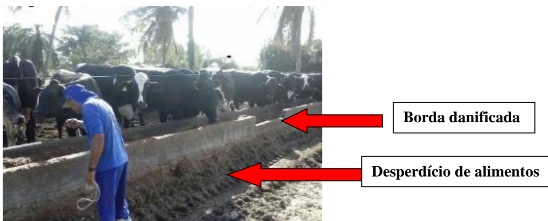
Figura 23. Borda do cocho danificada. Fonte: Cruz (2015).
