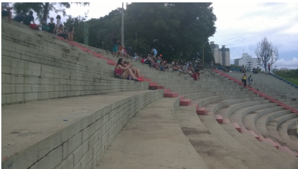
Figura 10. Vista parcial da arquibancada do anfiteatro no Parque Vitória Régia, Bauru
