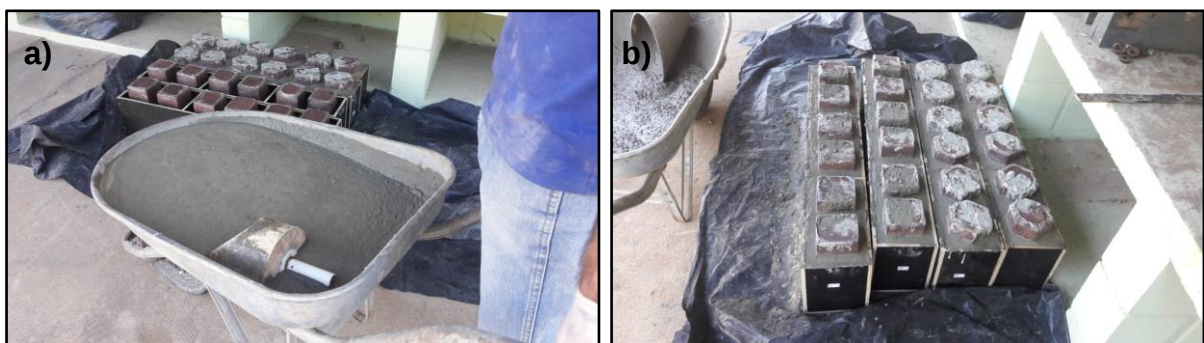
Figura 28 - Processo de fabricação dos blocos - a) Lançamento do concreto, b) Blocos após concretagem antes do acabamento final do topo
