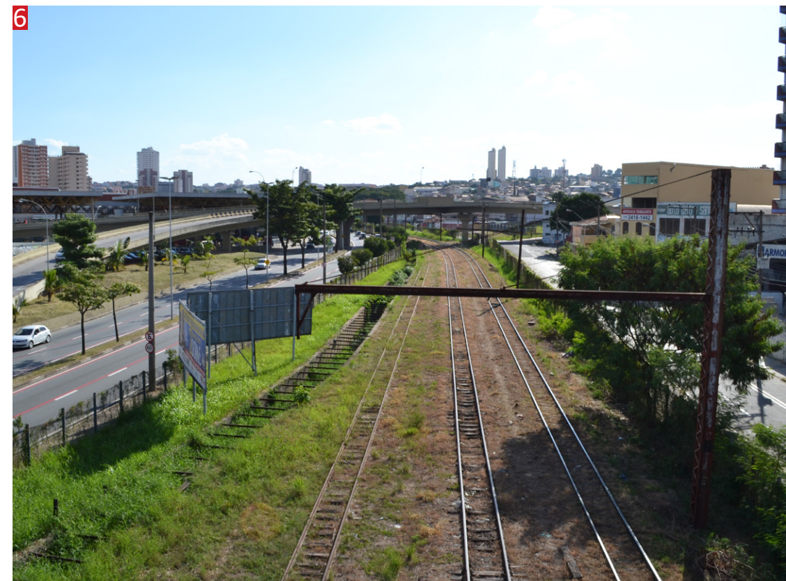
Figura 43: Fotografia do alto do Viaduto dos Ferroviários, tirada do percurso reservado aos pedestres. Destaque para o elemento vazio que perpassa pelo contexto estudado. Fonte: Acervo do autor.
