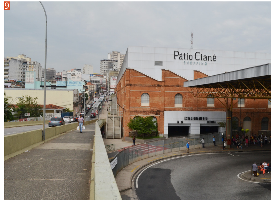
Figura 46: Fotografia do destaque para o ponto onde o viaduto Janio Quadros passa em frente ao terminal. Não há conexão direta, sendo necessário que os pedestres o percorram até o fim e, contornem por baixo do viaduto até chegar terminal de ônibus. Fonte: Acervo do autor.
