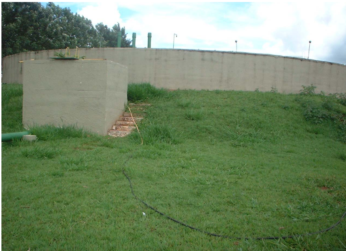
Figura 2 - Reator Anaeróbio de Lodo Fluidizado (RALF) da Estação de Tratamento de Esgoto (ETE), unidade Aero Rancho, Águas Guariroba, Campo Grande - MS
