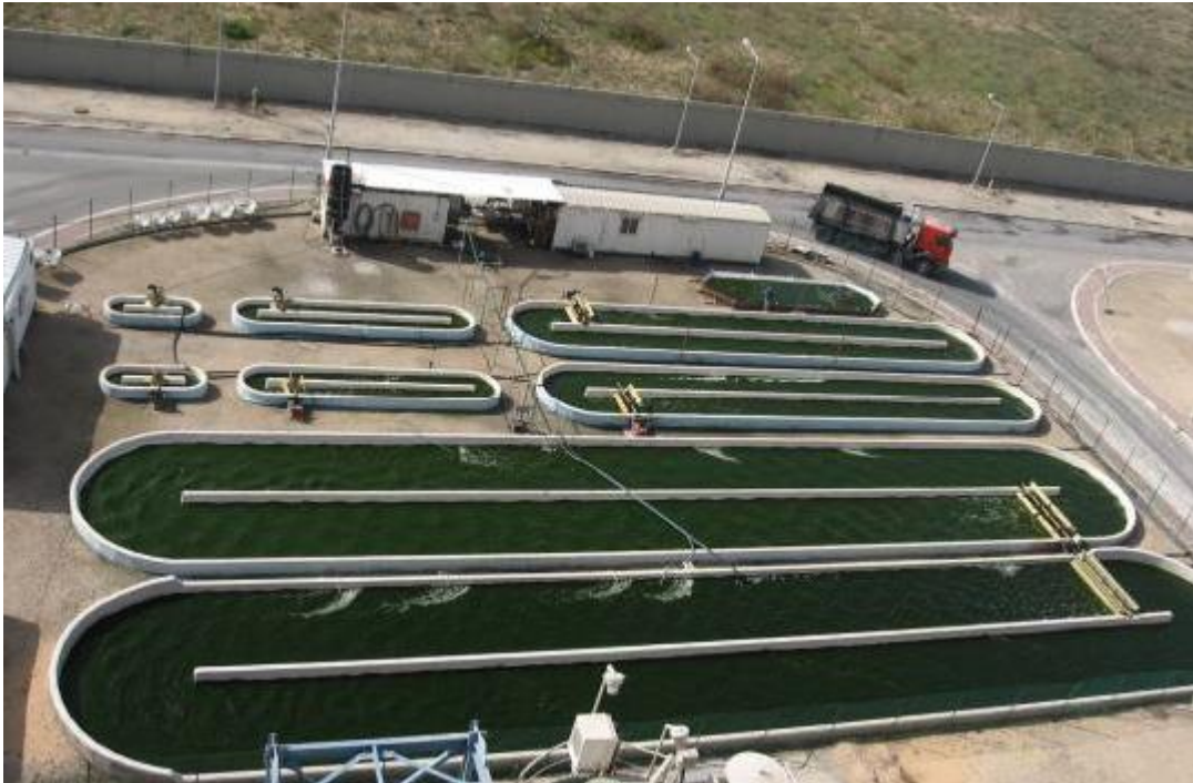
Figura 3 - Fotobiorreator Raceway de escala comercial
