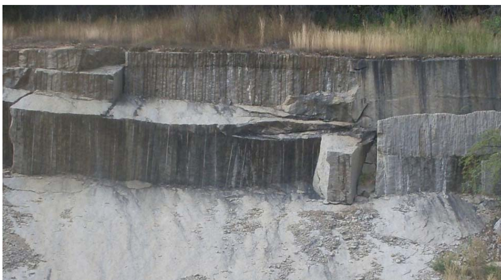
Figura 53 - Frente de lavra paralisada, do granito Meruoca Clássico, mostrando vestígios das tecnologias de corte utilizadas
