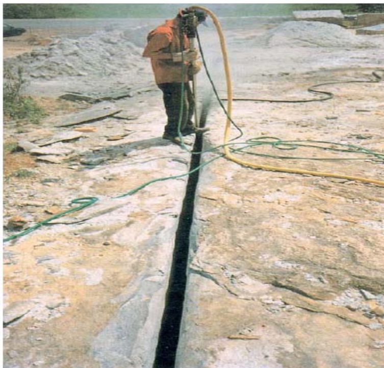
Figura 43 - Corte de rocha utilizando o flame jet
