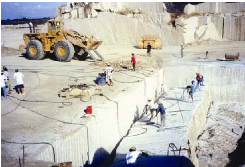
Figura 34 - Foto de lavra em bancada em granito
