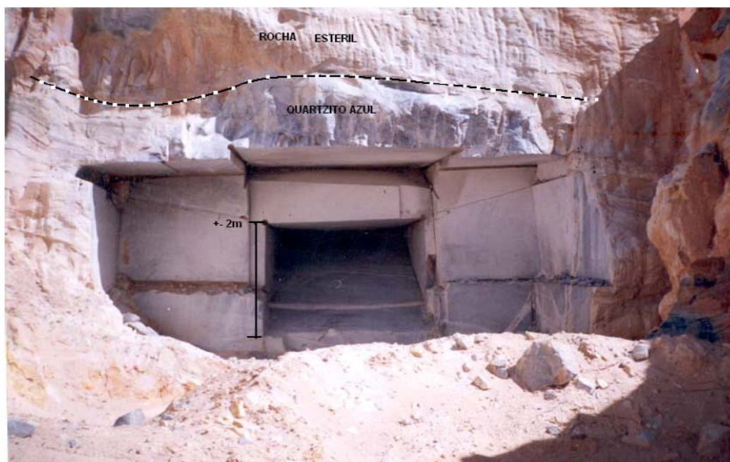
Figura 37 - Foto mostrando o início de lavra subterrânea do quartzito Azul Imperial, Oliveira dos Brejinhos Bahia
