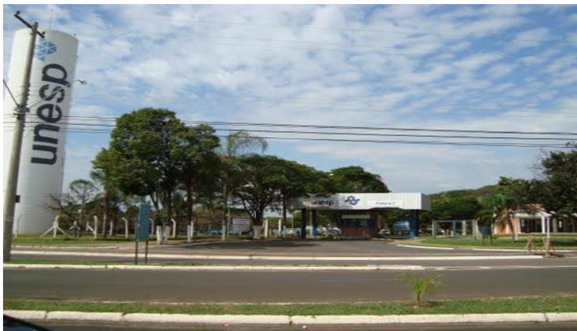
Figura 11 - Fotografia UNESP Campus Bauru
