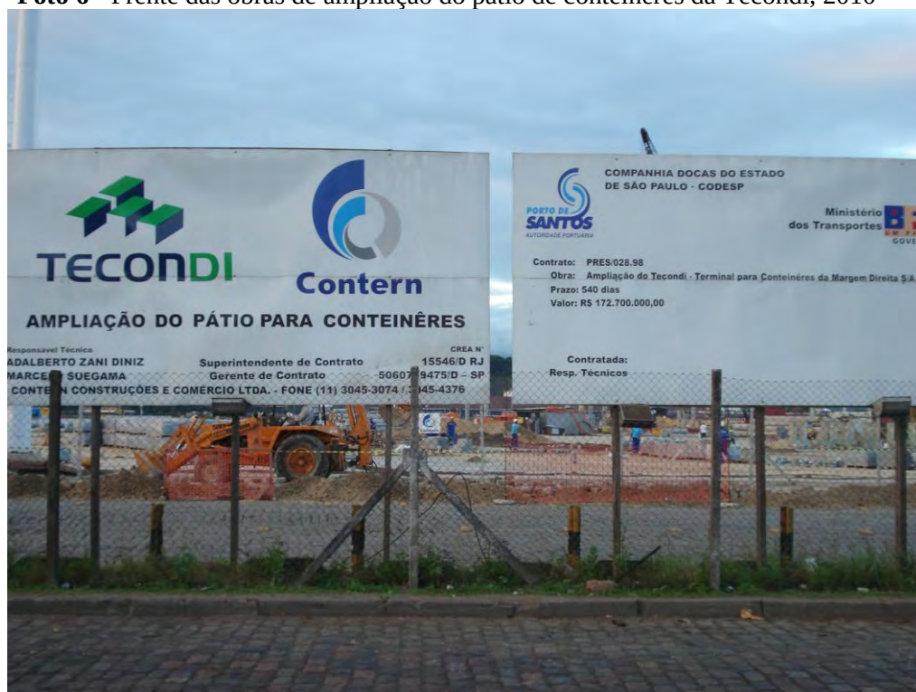
Foto 6 - Frente das obras de ampliação do pátio de contêineres da Tecondi, 2010
