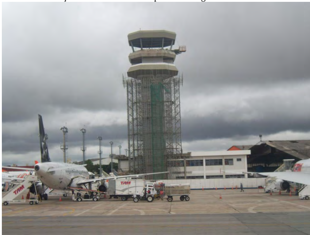
Foto 7 - Construção da nova torre no aeroporto de Congonhas
