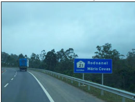
Foto 1- Trecho do Rodoanel Sul, 2010
