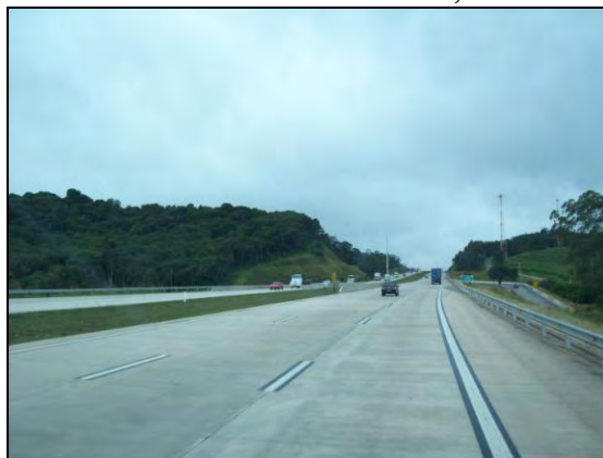
Foto 2 - Trecho do Rodoanel Sul, 2010
