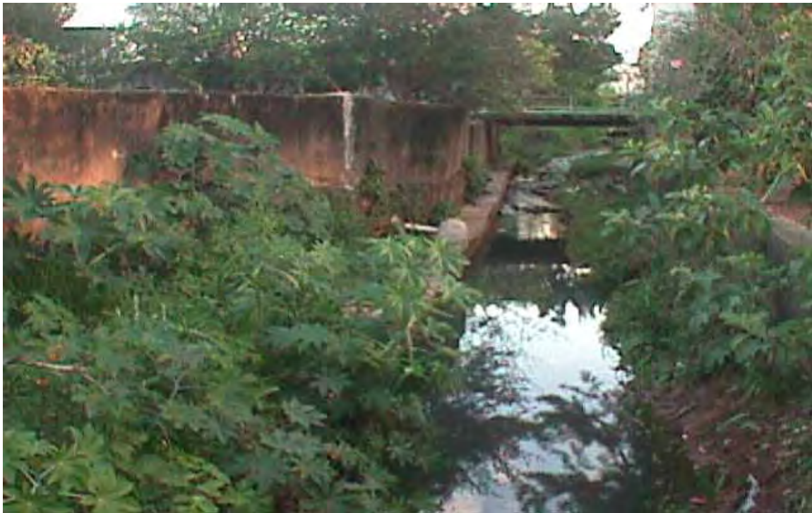
Foto 5: Canalização e ocupação em área de APP do Ribeirão Tijucu Preto na cidade de Rio das Pedras. Autor: Silveira (2007).
