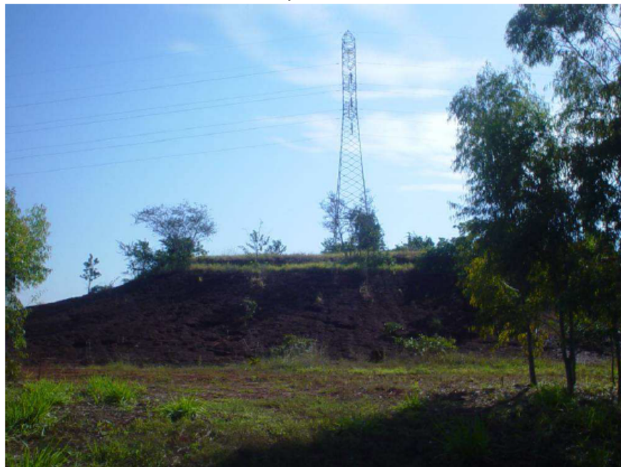
Figura 4.3 - Vista geral da área decapitada mostrando o corte de 8,6 m de espessura.
