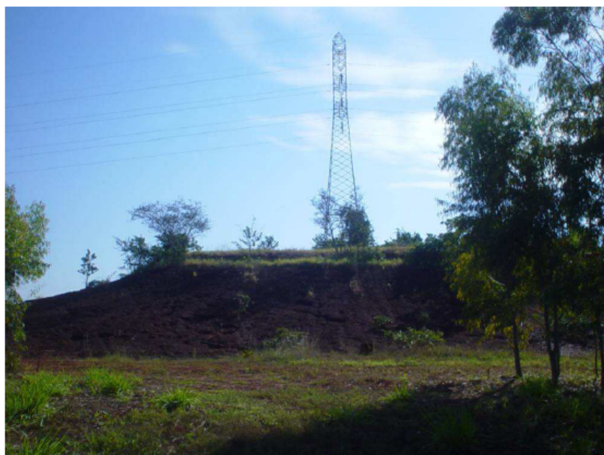
Figura 3.2 - Vista geral da área decapitada mostrando o corte de 8,6 m de espessura.
