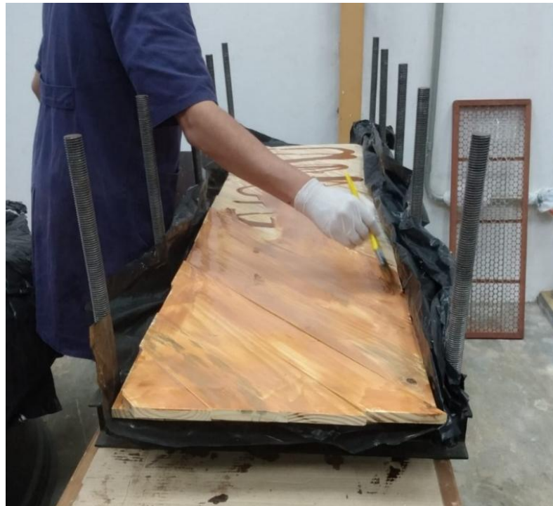
Figura 31 – Aplicação manual do adesivo poliuretano bicomponente (AG101) durante o processo de colagem dos painéis de MLCC.
