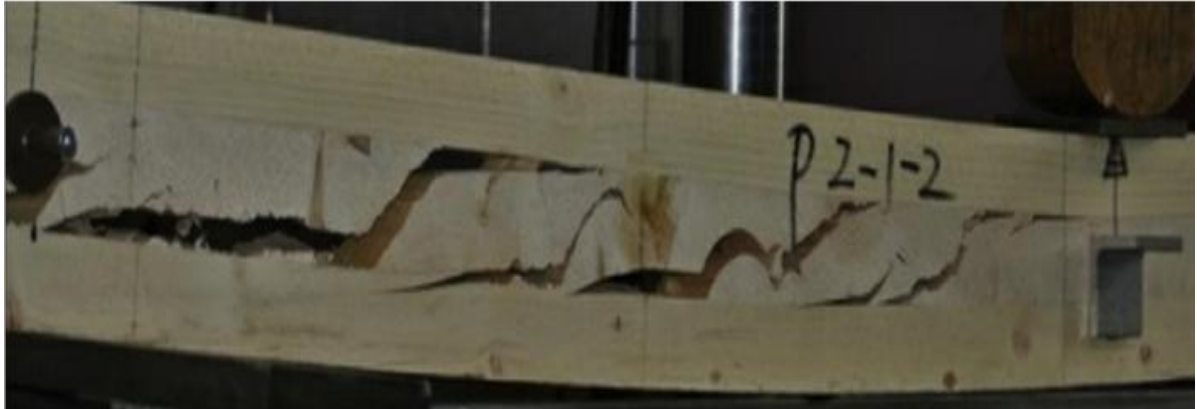
Figura 16 – Falha por rolling shear em um corpo de prova de MLCC submetido à flexão.
