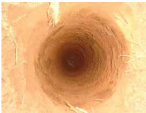
Figura 32 – Detalhe do furo da estaca antes da concretagem.
