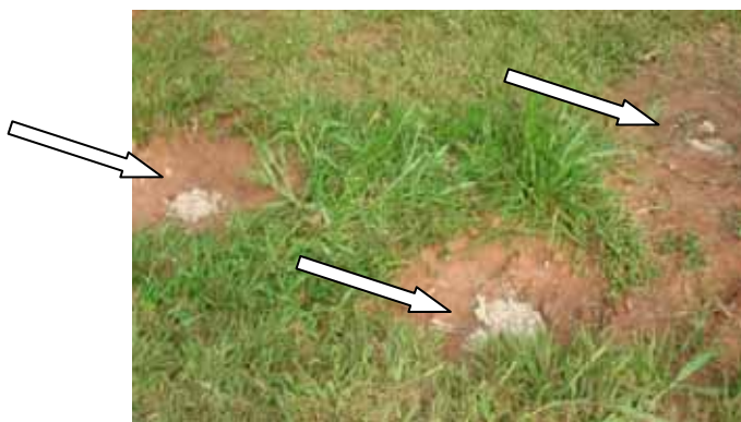
Figura 28 – Cura das mini-estacas no campo experimental.
