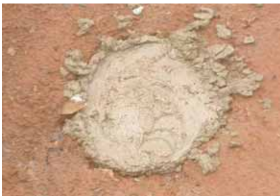
Figura 27 – Conclusão da concretagem de uma mini-estaca.
