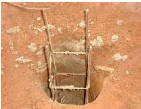
Figura 33 – Momento final da concretagem de uma das estacas.
