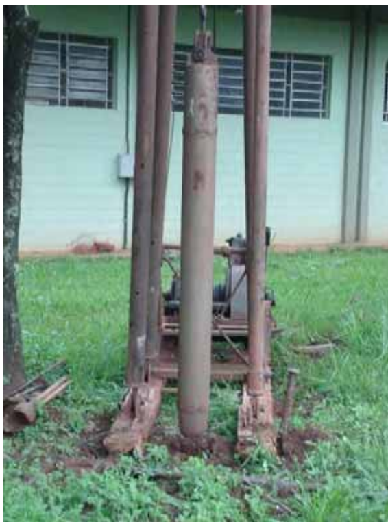
Figura 30 - Detalhe do pilão utilizado na confecção dos furos.
