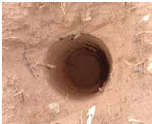
Figura 26 – Furo da mini-estaca realizado com trado manual de 10 cm.
