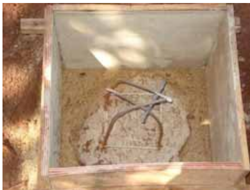
Figura 35 – Fôrma do bloco antes da concretagem.
