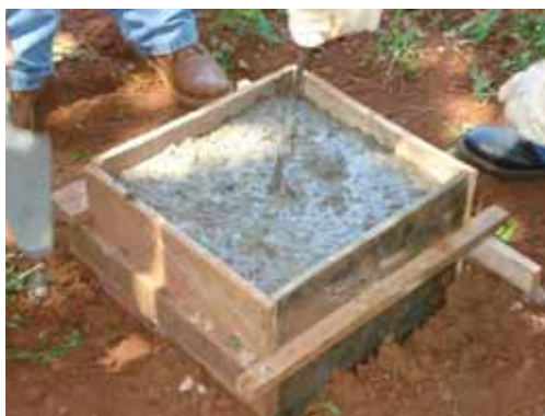
Figura 36 – Concretagem de um dos blocos.
