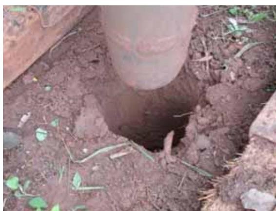
Figura 31 – Detalhe do início da abertura de um dos furos.
