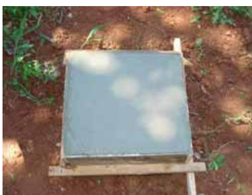
Figura 37 – Conclusão da execução de um dos blocos.
