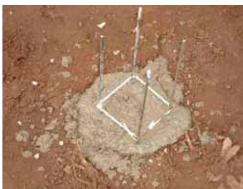
Figura 34 – Estaca pronta com os ferros de espera.
