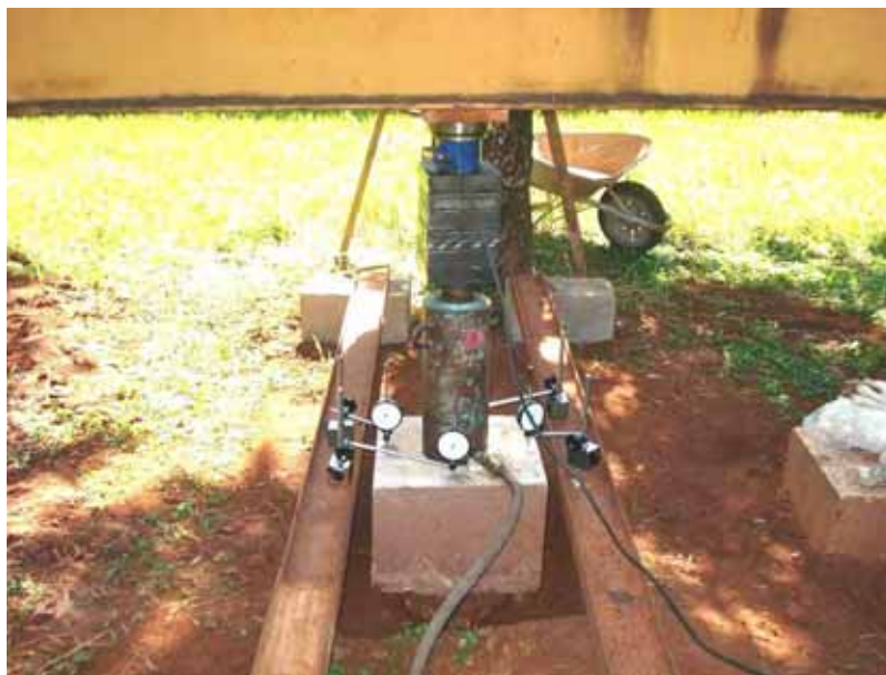
Figura 42 – Montagem da prova de carga.
