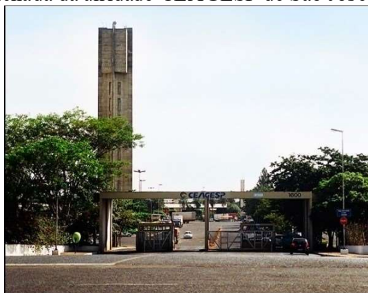
Foto 19 – Fachada da unidade CEAGESP de São José do Rio Preto.
