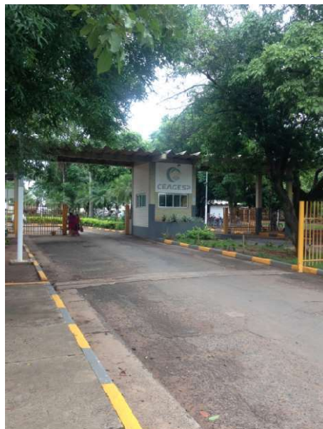
Foto 1 – Fachada da unidade da CEAGESP em Araçatuba
