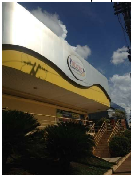
Foto 22 – Fachada do Proença Supermercado
