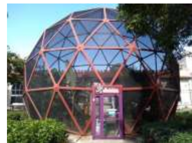
Foto 15. Prédio do borboletário.
