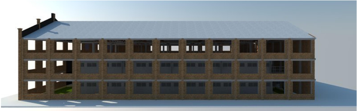
Figura 66- Detalhe da lateral do edifício, com os vãos reabertos.
