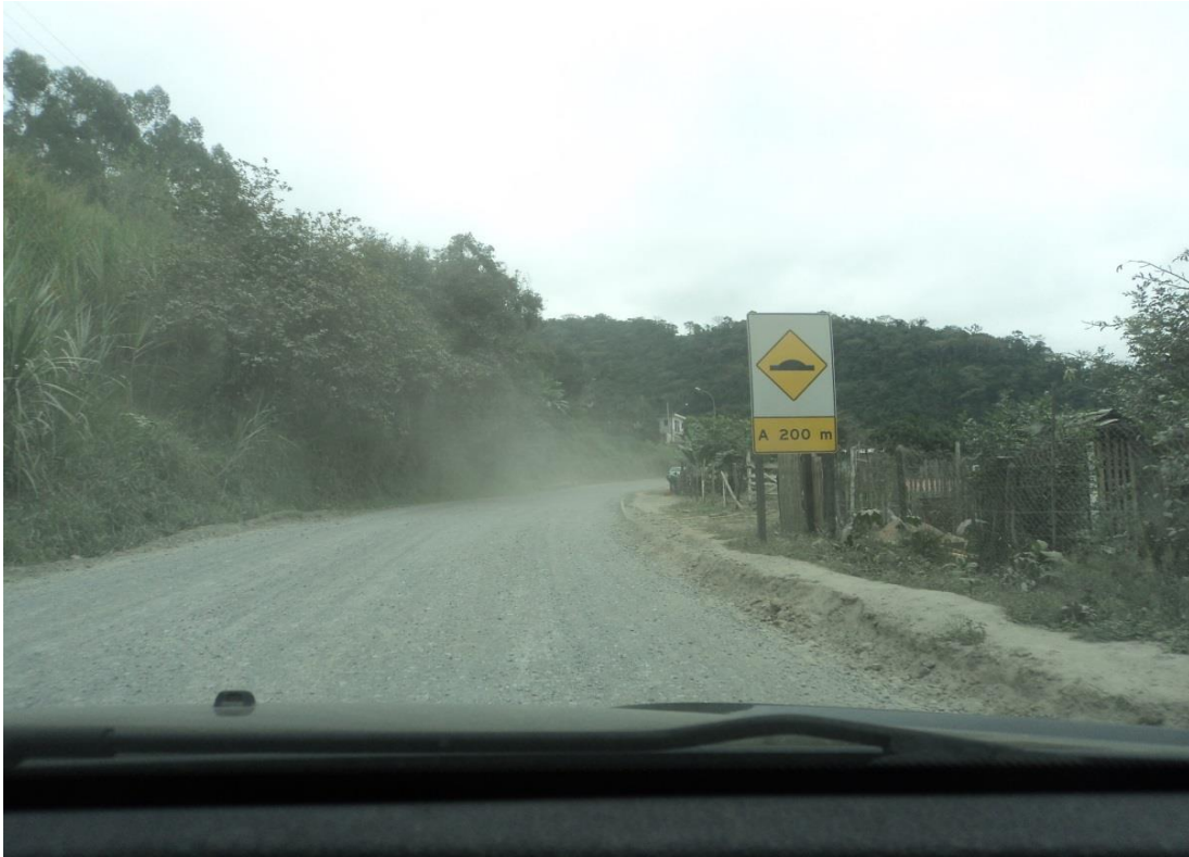
Imagem 9 Trecho sem cobertura de asfalto, presença de pedras, terra e poeira– fonte: Felipe Queiroz Miano
