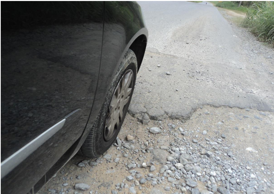
Imagem 8 Trecho sem porção do asfalto e presença de grandes buracos – fonte: Sérgio Queiroz Gonçalves Neto
