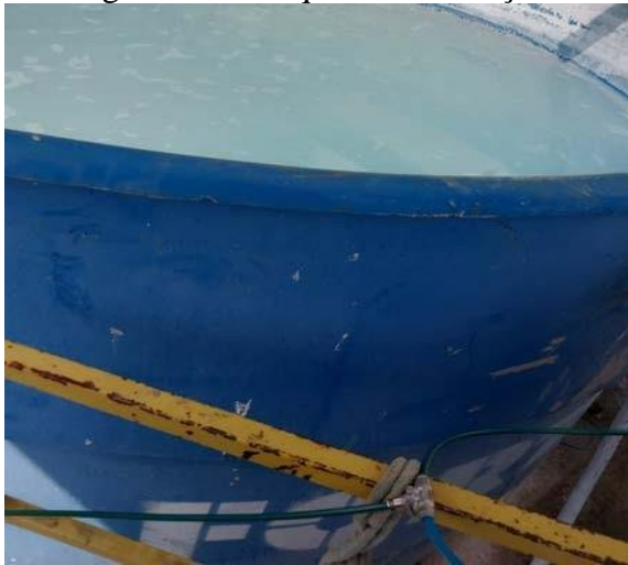
Figura 33 - Tanque de decantação
