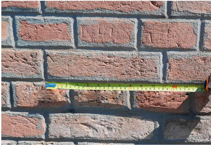
Figura 33: Medidas do tijolo maciço tipo 1. Fonte: Acervo pessoal da autora, 2024.
