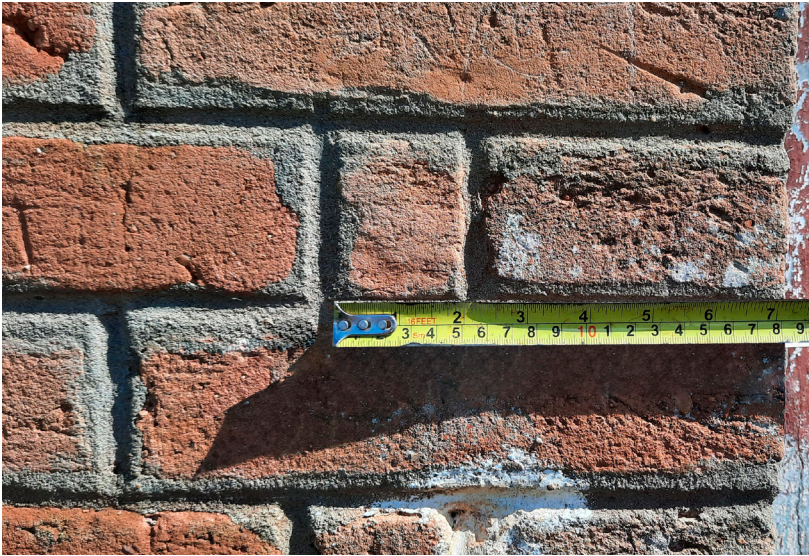
Figura 35: Medidas do tijolo maciço tipo 2. Fonte: Acervo pessoal da autora, 2024.
