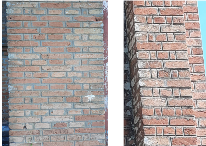
Figura 45 e 46: Pilares da Capela em assentamento inglês em tijolo misto. Fonte: Acervo pessoal da autora.
