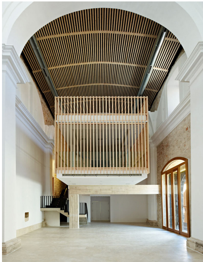
Figura 4: Intervenção na La Capilla de Brihuega. Fonte: Eugeni Pons, 2012.
