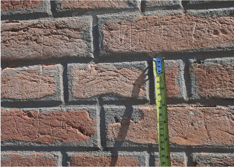
Figura 34: Medidas do tijolo maciço tipo 1. Fonte: Acervo pessoal da autora, 2024.
