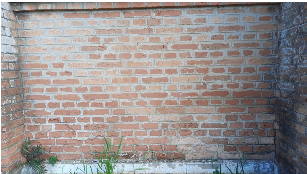
Figura 41: Parede da Capela em assentamento inglês em tijolo maciço. Fonte: Acervo pessoal da autora.
