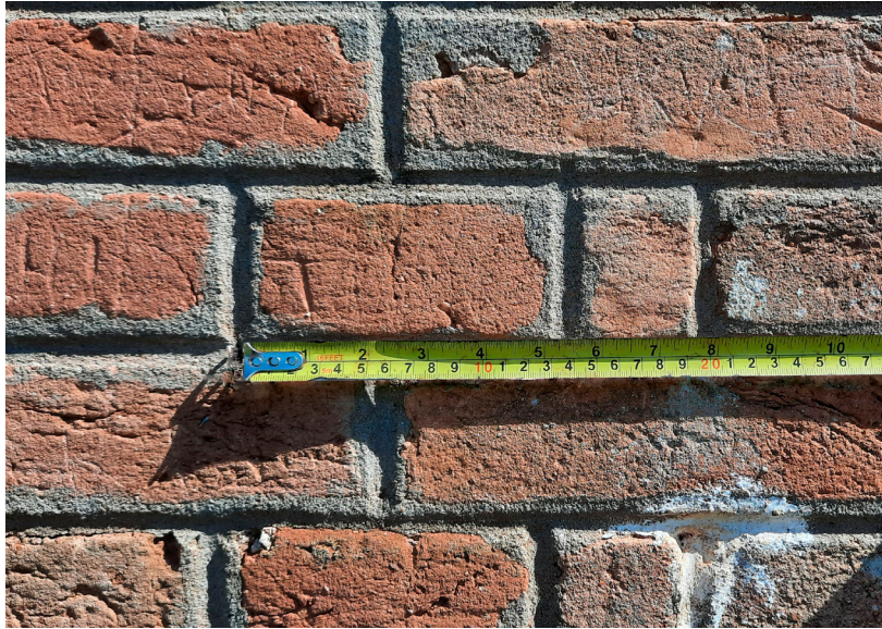
Figura 32: Medidas do tijolo maciço tipo 1. Fonte: Acervo pessoal da autora, 2024.
