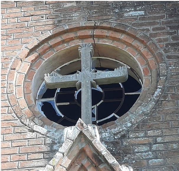
Figura 16: Argamassa armada presente em elementos da fachada. Fonte: Acervo pessoal da autora, 2024.
