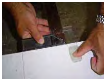
Fixação dos suportes acrílicos
