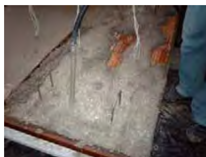
Lançamento e adensamento do concreto
