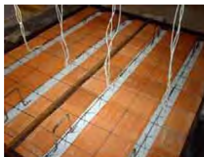
Posicionamento dos fios
