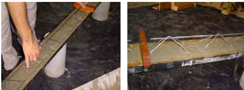
Figura 22: Moldagem das vigotas pré-moldadas treliçadas
