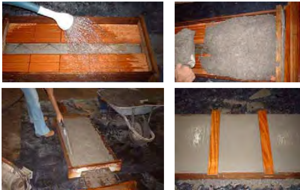
Figura 24: Concretagem da capa dos modelos M-100
