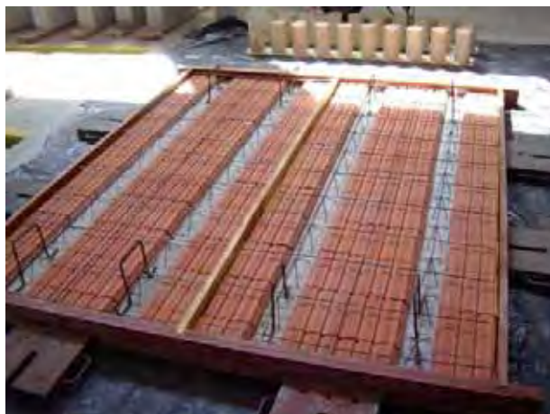
Figura 26: Posicionamento de ganchos e armadura de distribuição nos modelos M-210
