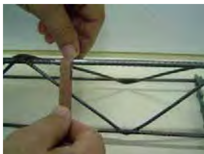
Preparo da superfície
