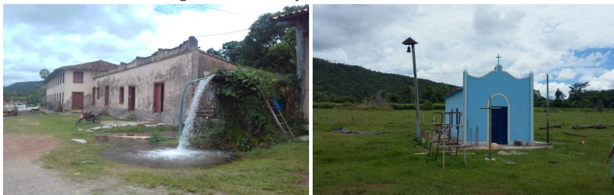
Figura 36 – Edificações da Fazenda Jacobina
