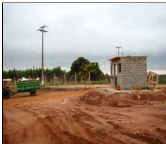
Foto 85 - Construção de guarita na entrada do aterro controlado.
