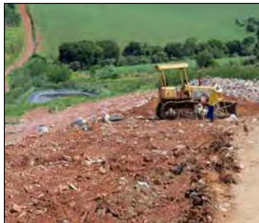
Foto 39 – Máquina utilizada para realizar a cobertura dos resíduos. Fonte: Cantóia, 2010.
