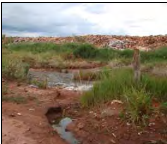
Fotos 3 e 4 - Chorume misturado com águas pluviais e formação de lagoa.
