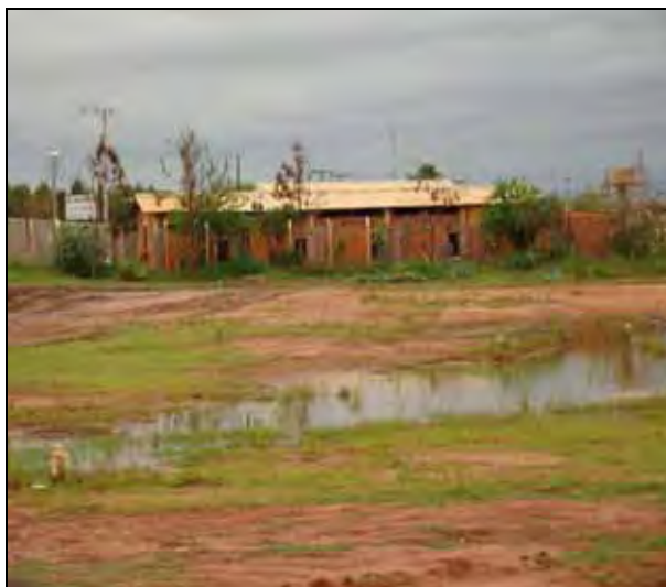
Foto 83 - Construção sobre a antiga área de disposição final de resíduos em Ourinhos.
