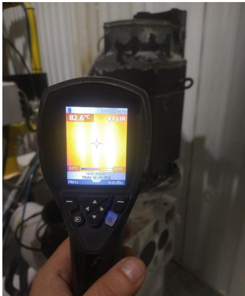
Figura 25 – Aplicação de uma câmera termográfica na inspeção de painéis elétricos
