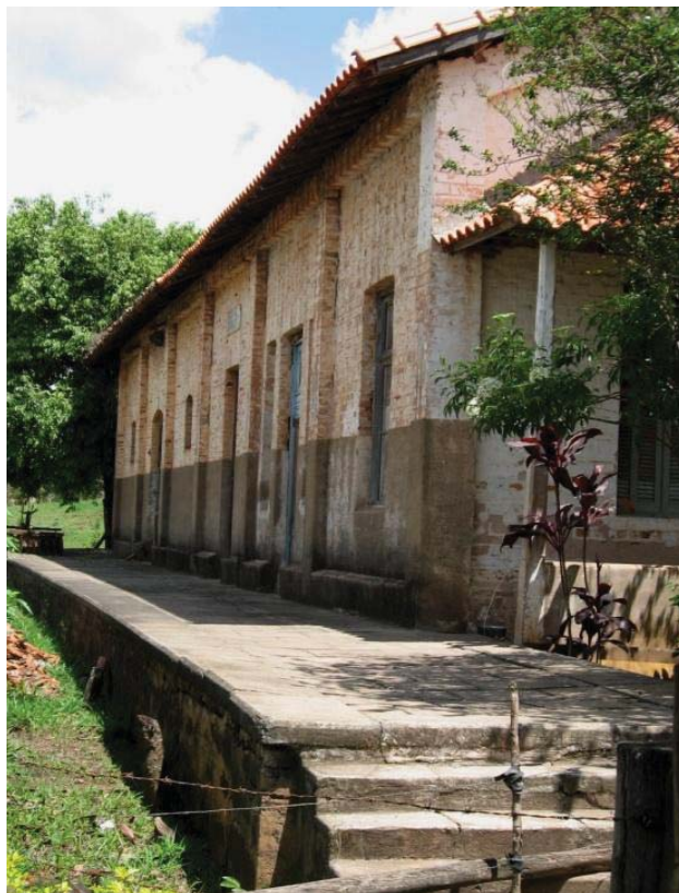
Figura 15. Antiga estação ferroviária no Distrito de Ferraz./(Foto de FERREIRA, D. A. O., 2011)
