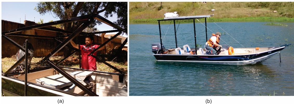
Figura 11: Segunda estrutura desenvolvida para a instalação do escâner na embarcação; (a) Detalhe do sistema articulado da estrutura; (b) estrutura montada com destaque para os estirantes.
