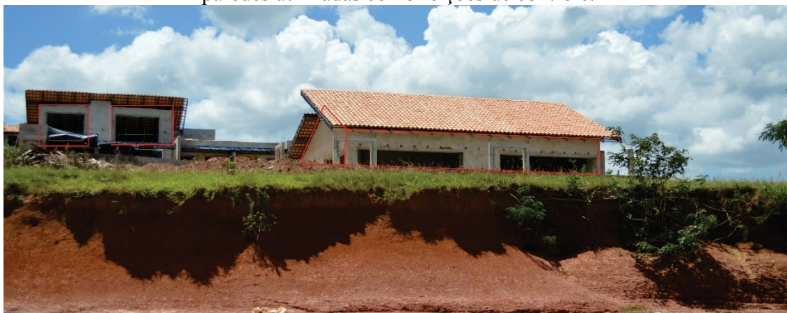
Figura 26: Edificações às margens do reservatório de Chavantes com destaque para as paredes utilizadas como feições de controle.
