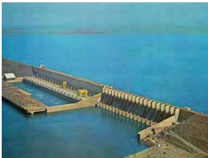
Figura 2. Usina Hidrelétrica de Ilha Solteira.
