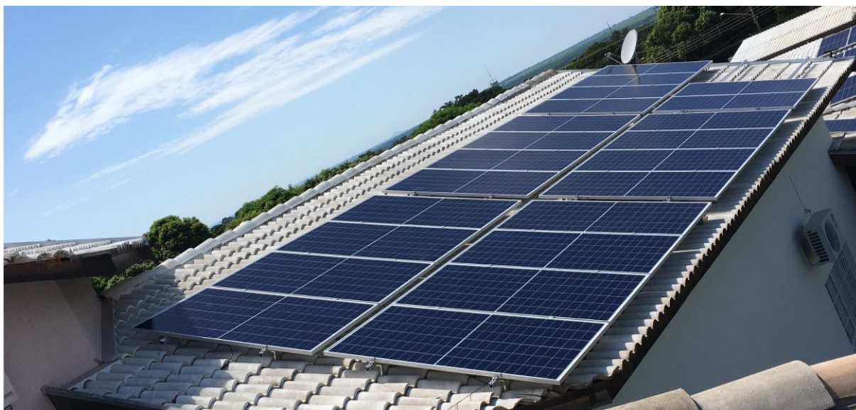
Figura 14: Vista lateral dos módulos da residência (telhado oeste).
