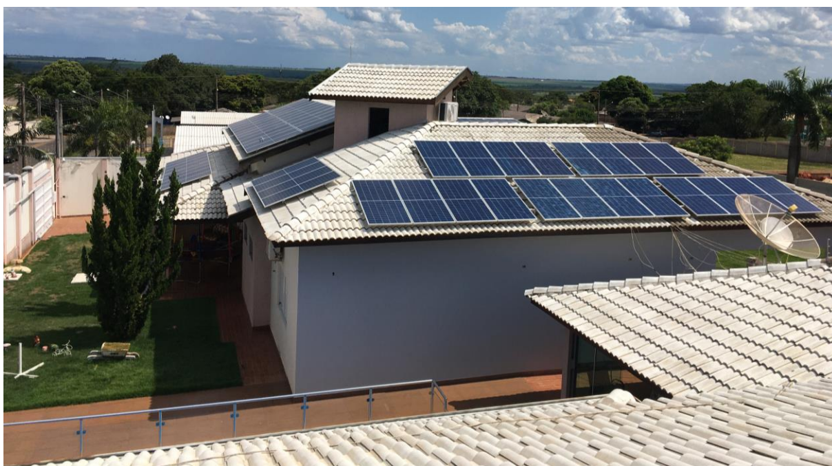
Figura 15: Vista frontal dos módulos da residência (telhado leste e oeste).
