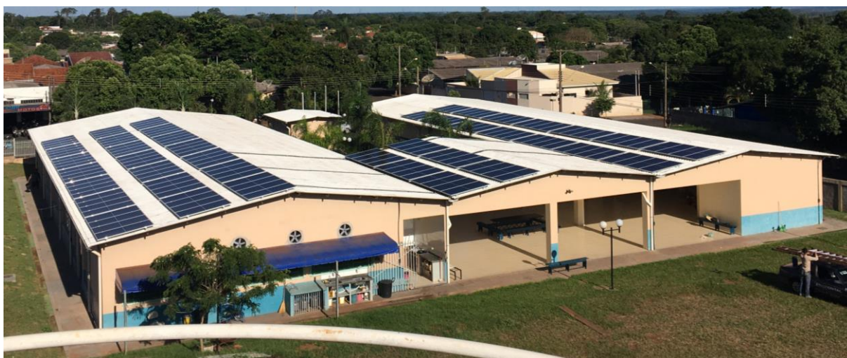
Figura 12: Disposição dos Módulos Fotovoltaicos da entidade
