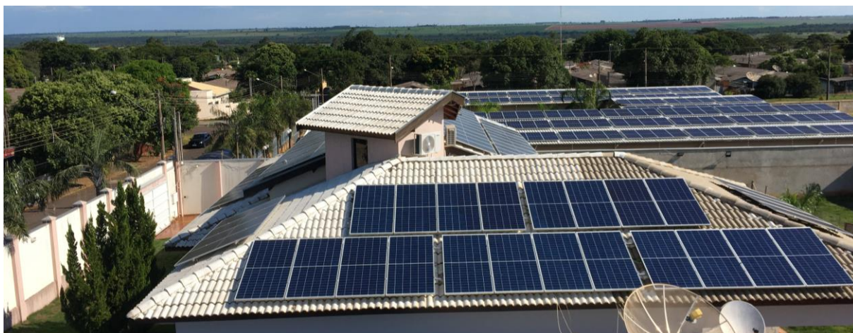
Figura 16: Vista dos módulos da residência (telhado leste e oeste ao fundo e norte à frente).
