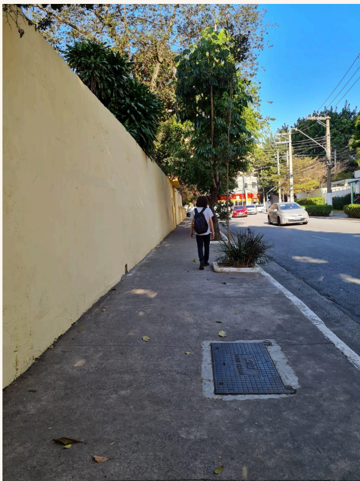
Fotografia 4 —Registro do muro sem artes da Pedro II
