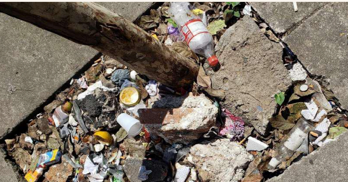
Figura 3 — Foto de buraco na rua funcionando como local de descarte
