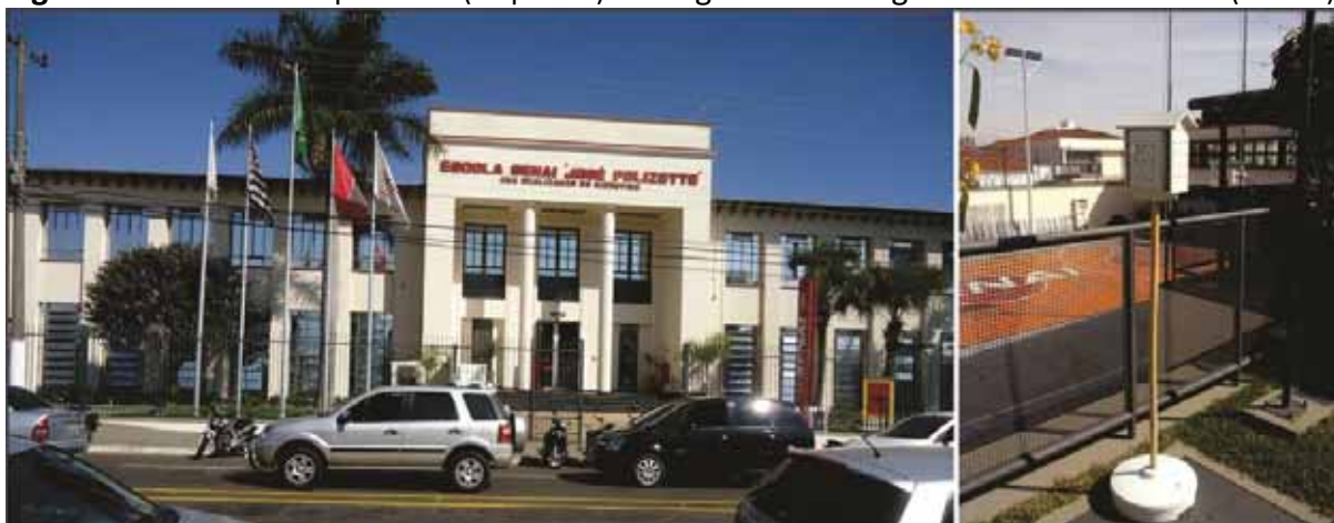
Figura 42- Fachada do ponto 10 (esquerda) e abrigo meteorológico no interior do lote (direita).
