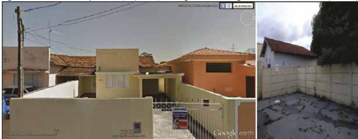
Figura 22- Fachada do ponto 4 (esquerda) e abrigo meteorológico no interior do lote (direita).
