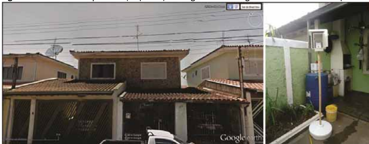
Figura 21- Fachada do ponto 3 (esquerda) e abrigo meteorológico no interior do lote (direita).
