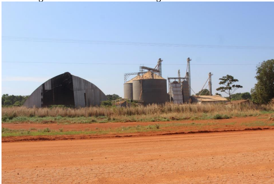
Imagem 42: Armazenadora da Cargill na BR-158 desativada
