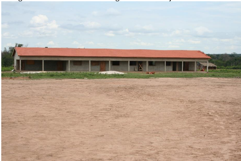
Imagem 34: Prédio da Escola Indígena em construção em Marãiwatsédé
