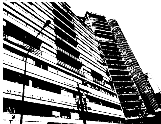
Edifício Esther em frente à Praça da República. Fotografia Taís Schiavon. Outubro de 2011.
