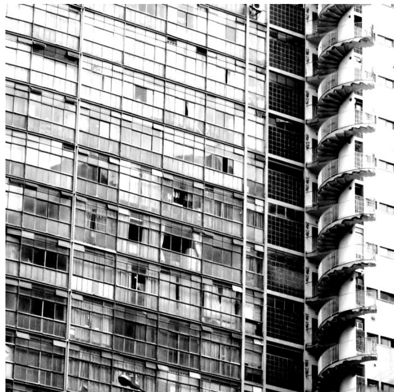
Copan, fachada oposta à Avenida Ipiranga, São Paulo. Fotografia Taís Schiavon, Outubro de 2011.
