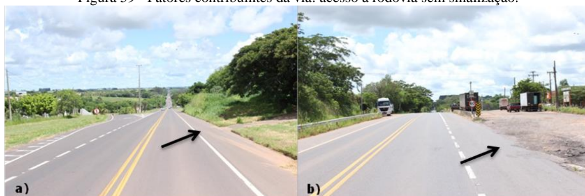
Figura 59 - Fatores contribuintes da via: acesso à rodovia sem sinalização.
