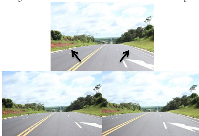
Figura 44 - Tríade de imagens geradas pelo sistema: câmera central (acima), esquerda e direita. Segmento de trecho 7 “sem acostamento” em destaque.
