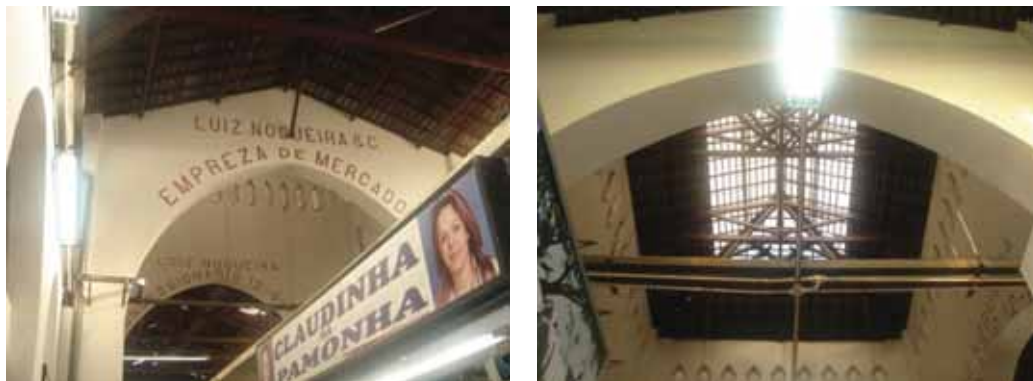
Figura 33 e 34 - Detalhe da estrutura em arco, treliça em madeira e cobertura com telha de barro (Fonte: Elton Maeda)
