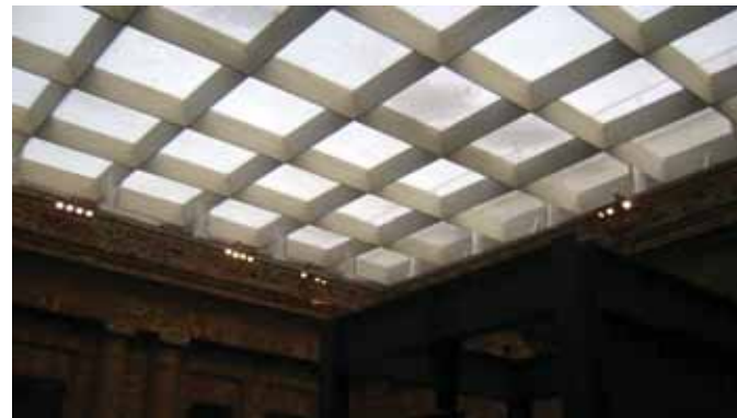
Figura 43 – Detalhe da materialidade da clarabóia (Fonte: Elton Maeda)
