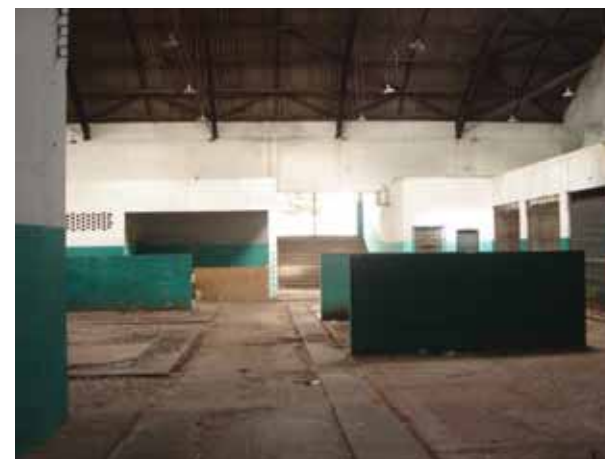
Figura 41 - Vista do interior - Mercado Municipal de Tupã (Fonte: Elton Maeda)
