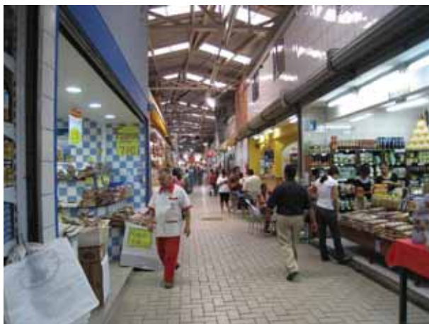
Figura 31 - Detalhe da cobertura – Mercado Municipal da Lapa (Fonte: Site http://www.sampa.art.br/cidade/mercadolapa/ )
