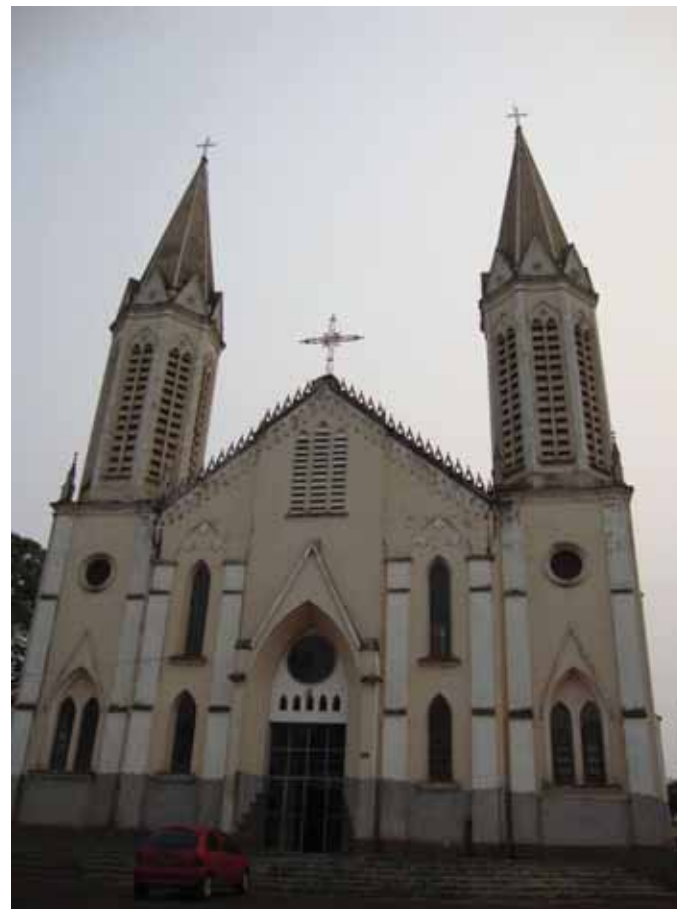
Figura 10 - Fachada principal da Matriz de São Pedro atualmente. (Fonte: Elton Maeda)
