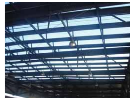
Figura 57 – Detalhe dos Sheds (Iluminação Zenital) (Fonte: Elton Maeda)
