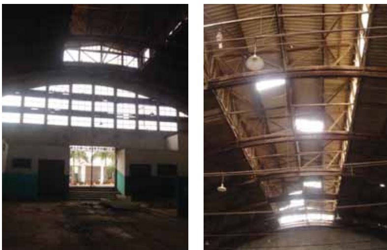
Figura 39 e 40 - Detalhe da treliça em madeira, cobertura de aço galvanizado e arcos da fachada (Fonte: Elton Maeda)
