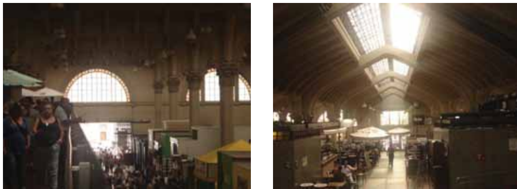
Figura 36 e 37 - Detalhe da estrutura em arco, Estrutura em concreto e iluminação zenital (Fonte: Elton Maeda)
