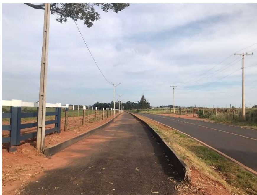
Figura 10: Foto da ciclovia em construção na ECH – 010 – vista 1
