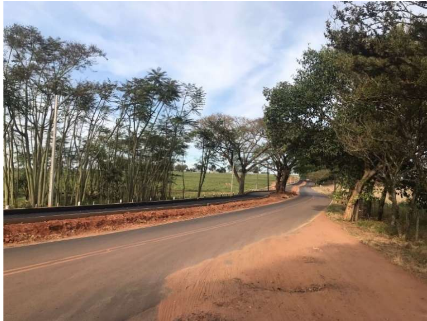
Figura 11: Foto da ciclovia em construção na ECH – 010 – vista 2
