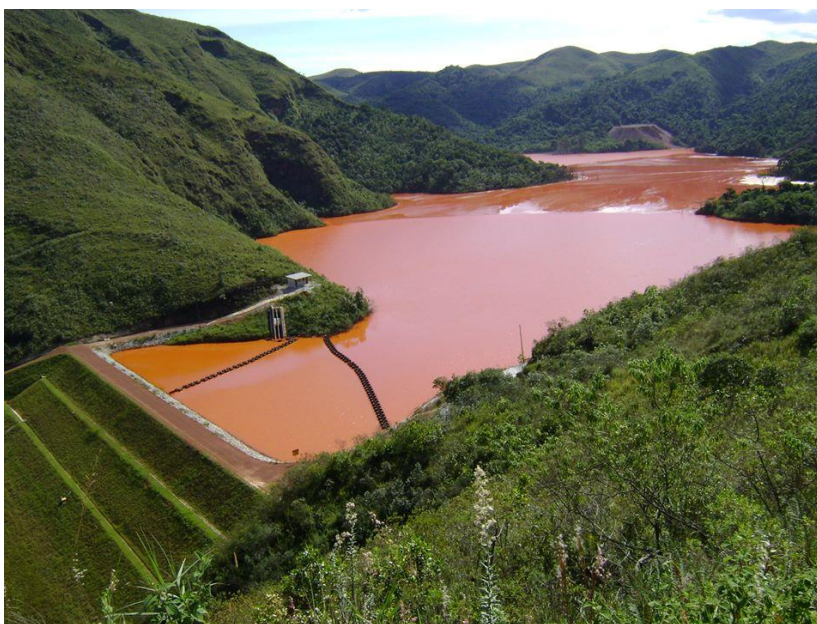
Figura 4.2: Barragem de rejeito em Mariana, Minas Gerais.
