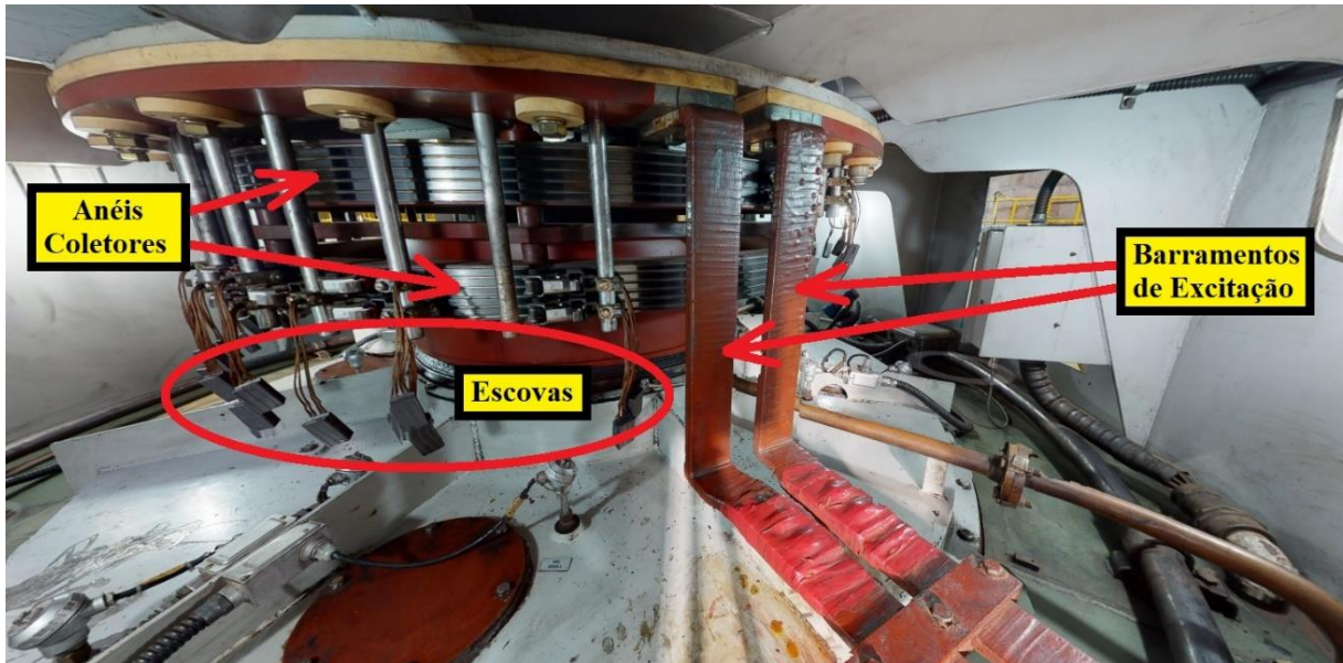
Figura 23 - Anéis coletores e escovas - UHE São Simão.
