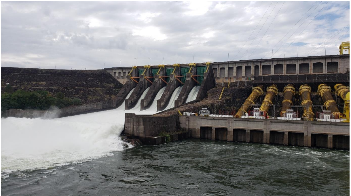
Figura 5 - UHE Salto Osório 1078 MW (Quedas do Iguaçu - PR, Brasil).
