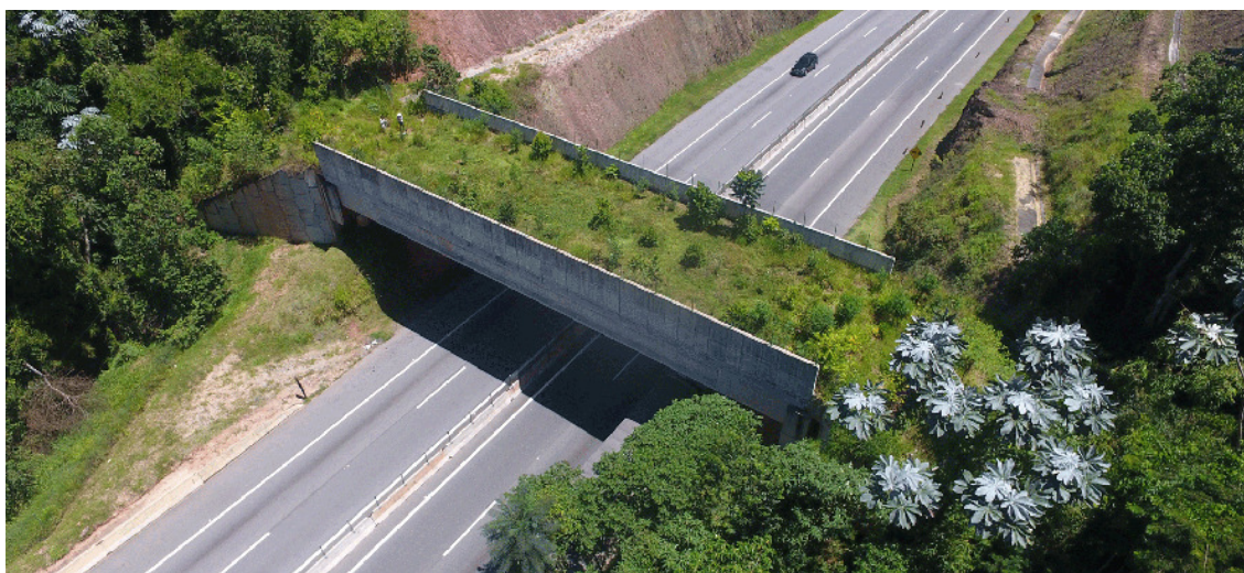
FIGURA 1. Passagem de fauna na Rodovia Tamoios no município de Paraibuna (SP). Fonte: Desenvolvimento Rodoviário S.A. (DERSA).
