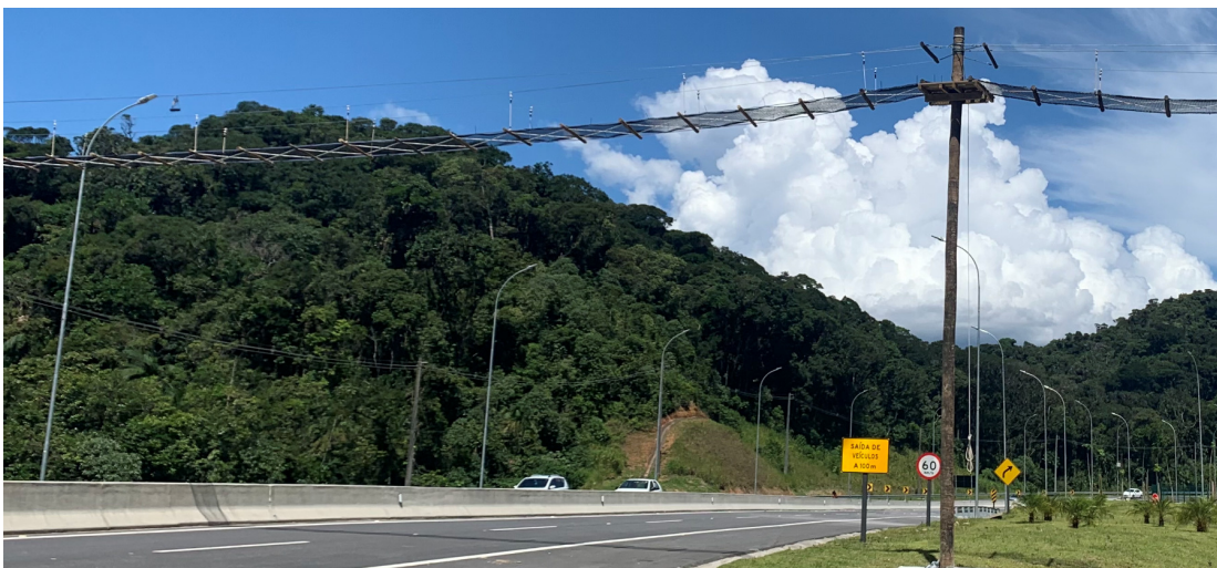
FIGURA 5. Passagem de fauna aérea localizada no km 65+610 da Rodovia Tamoios, no trecho de planalto de Caraguatatuba (SP). Fonte: Concessionária Tamoios.
