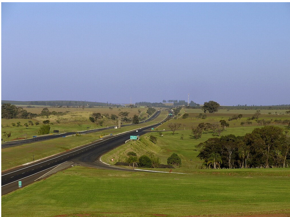
FIGURA 10. Trevo da rodovia Castelo Branco (SP-280), no km 241, no cruzamento com a SP-255, no município de Avaré, localizado no estado de São Paulo, Brasil. Fonte: José Reynaldo da Fonseca.
