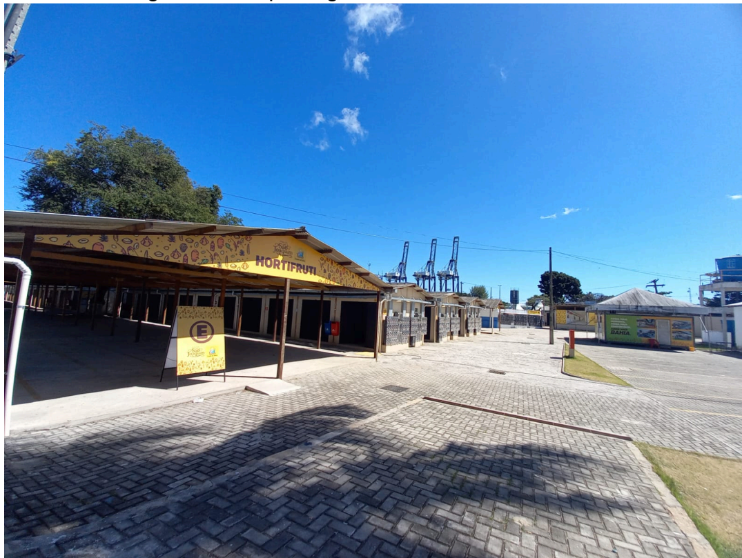
Figura 17: Galpão Água de Meninos - Vista lateral.
