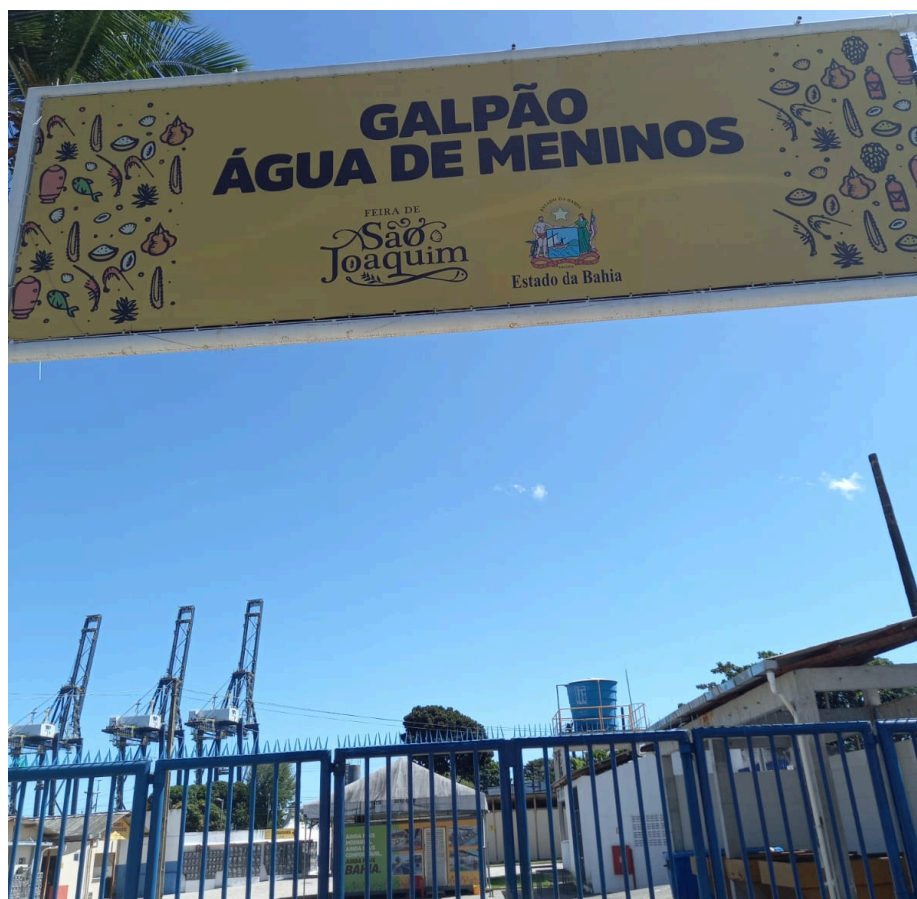
Figura 18: Galpão Água de Meninos - Vista da fachada.
