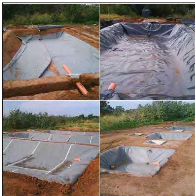
Figura 24 - Instalação da geomembrana e geotêxtil não tecido.
