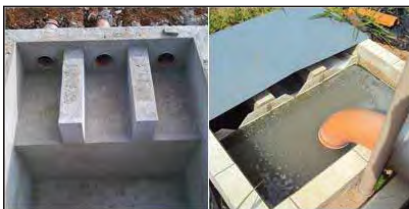
Figura 21 - Execução da caixa de distribuição.
