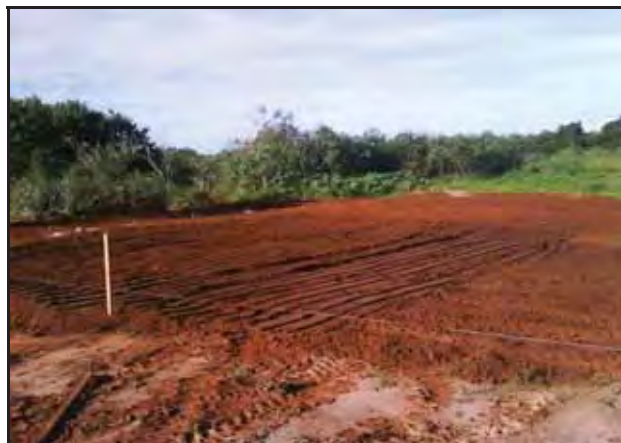
Figura 19 - Terreno após a execução do serviço de terraplenagem.
