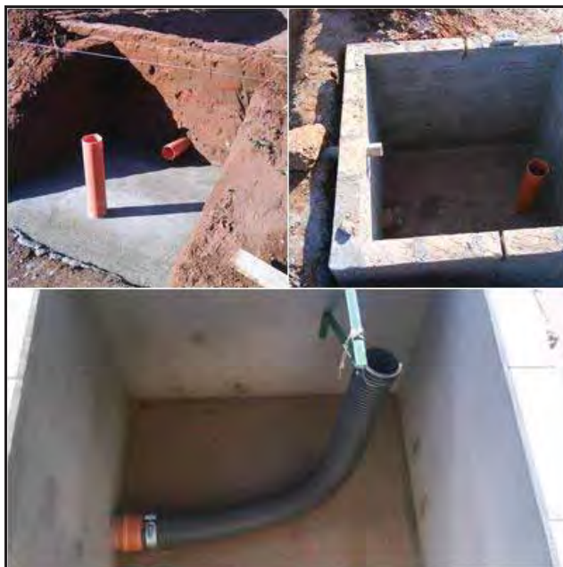
Figura 22 - Execução das caixas de passagem.
