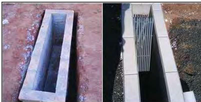
Figura 29 - Detalhe da construção do sistema de gradeamento.
