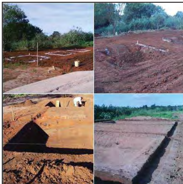
Figura 20 - Execução dos Alagados Construídos.
