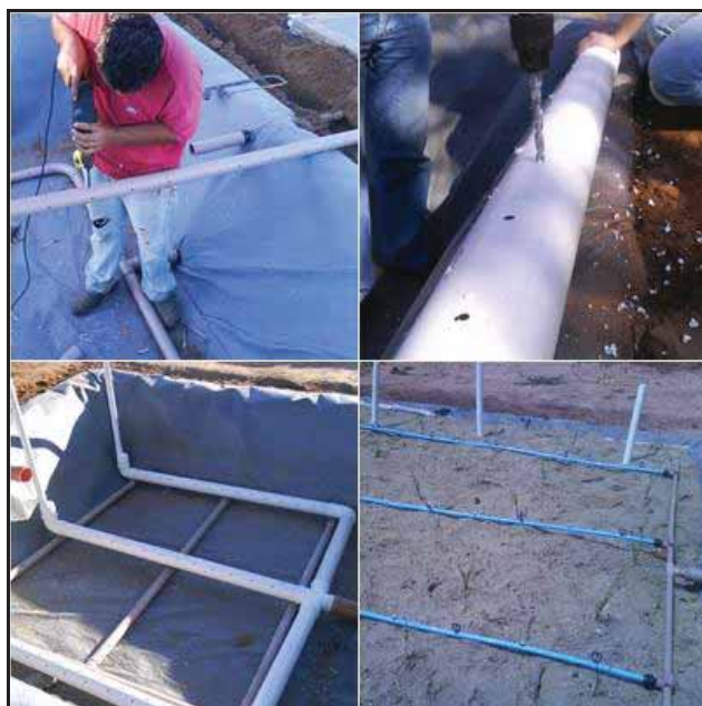
Figura 25 - Instalação do Sistema de Recirculação.
