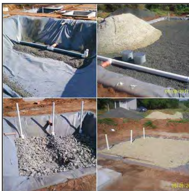
Figura 26 - Preenchimento dos leitos com os substratos.
