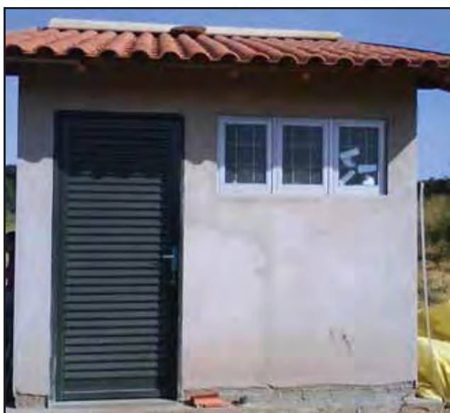
Figura 28 - Depósito para armazenamento de materiais.
