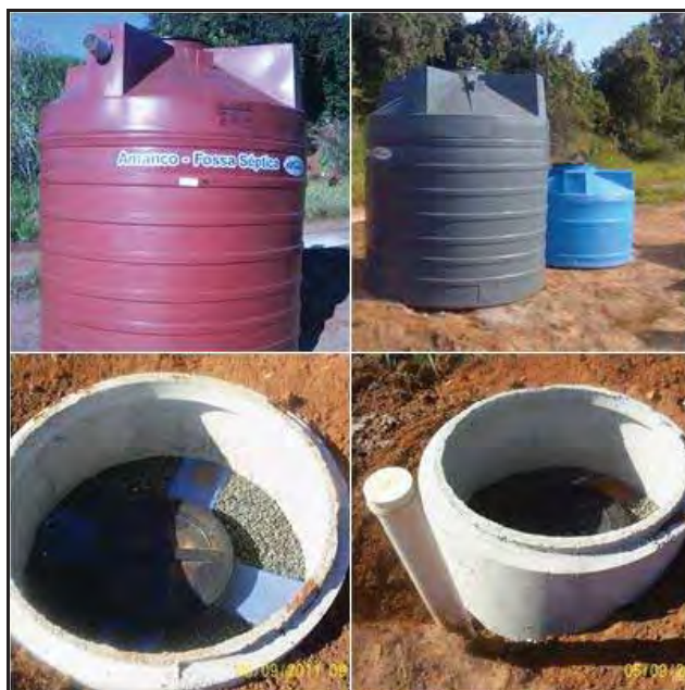
Figura 30 - Instalação dos Reservatórios.
