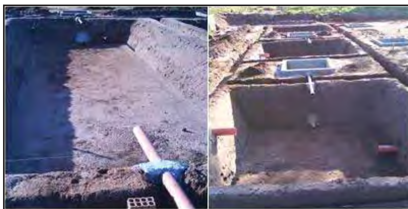
Figura 23 - Instalação das tubulações.
