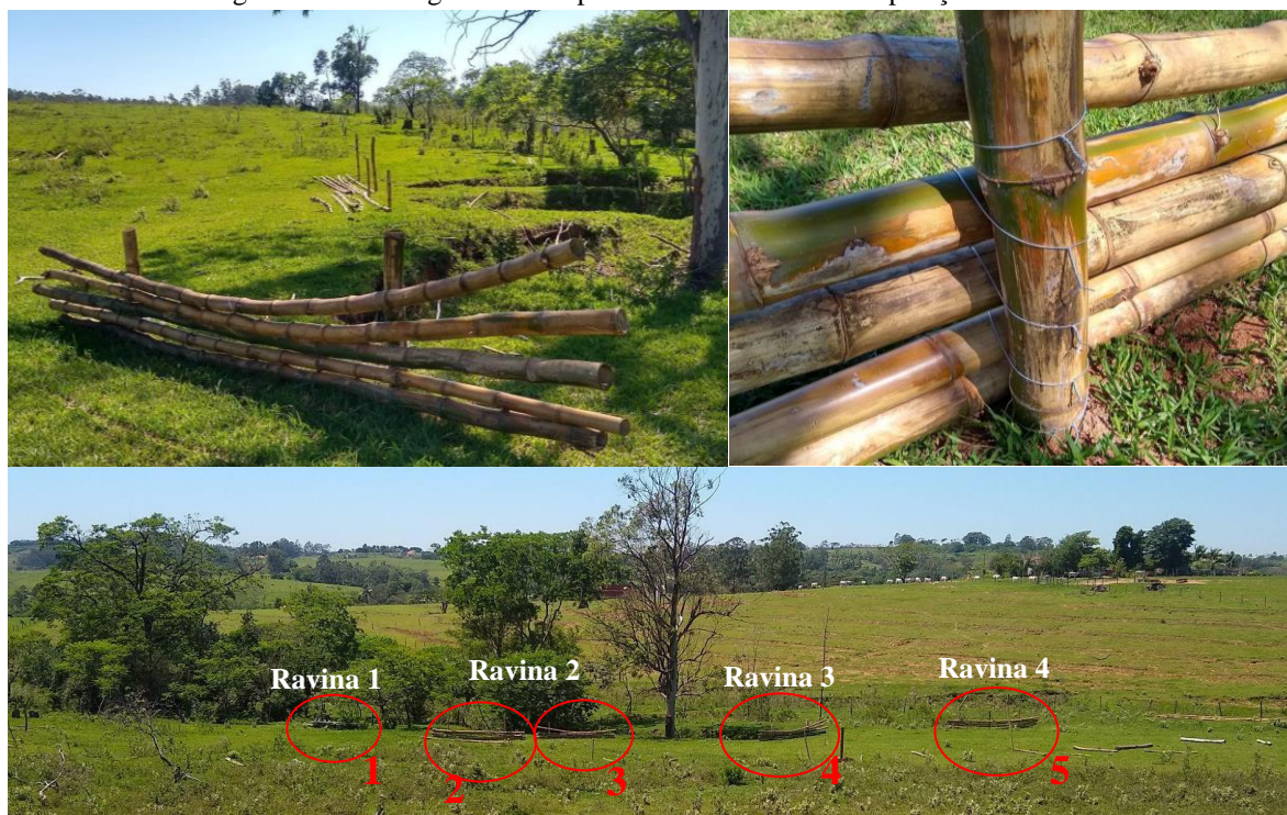
Figura 22 – Montagem em campo dos barramentos e a disposição dos mesmos.
