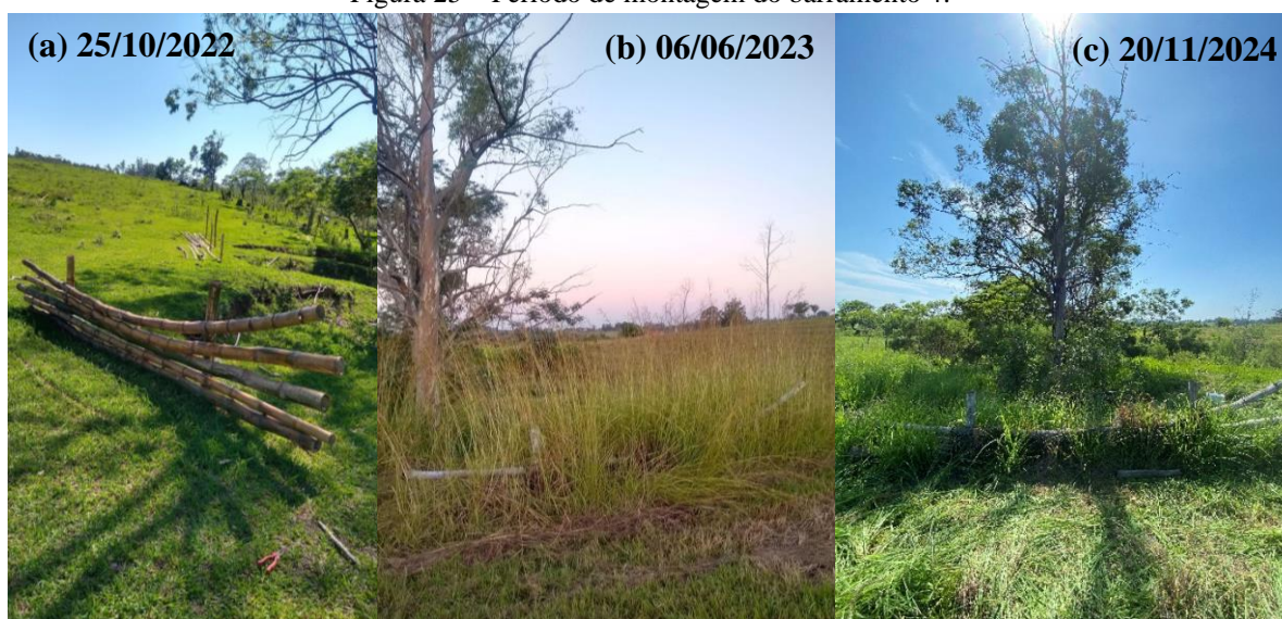
Figura 25 – Período de montagem do barramento 4.
