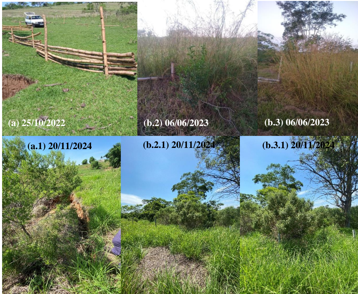
Figura 24 – Período de montagem dos barramentos 2 e 3.
