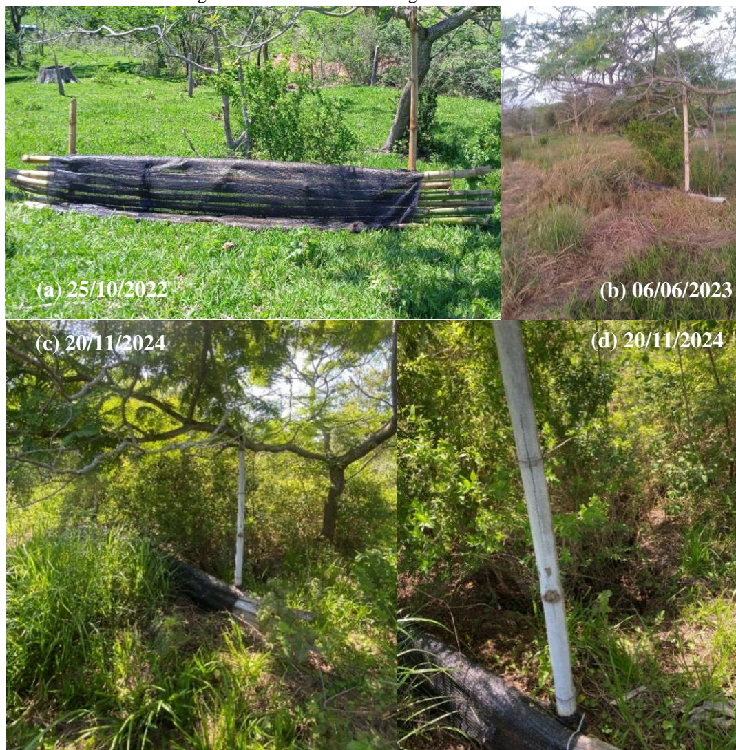
Figura 23 – Períodos de montagem do barramento 1.
