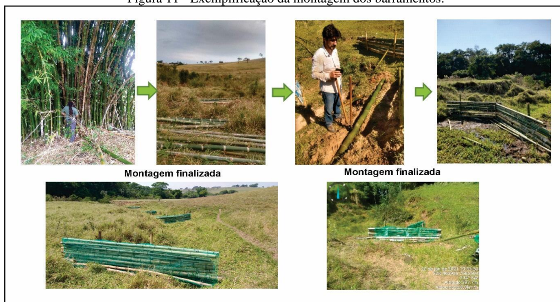
Figura 11 - Exemplificação da montagem dos barramentos.
