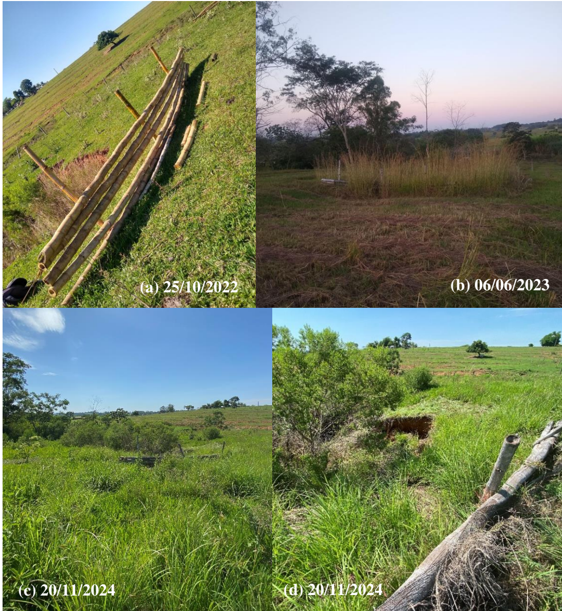
Figura 26 – Período de montagem do barramento 5.
