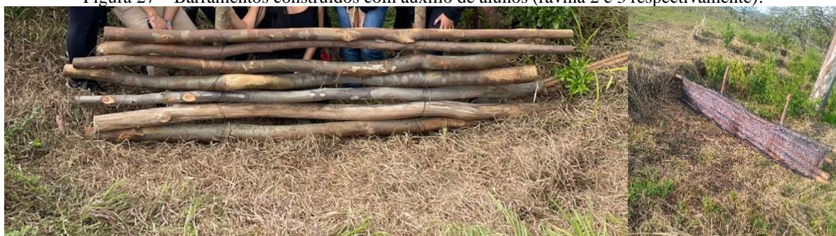
Figura 27 – Barramentos construídos com auxílio de alunos (ravina 2 e 3 respectivamente).
