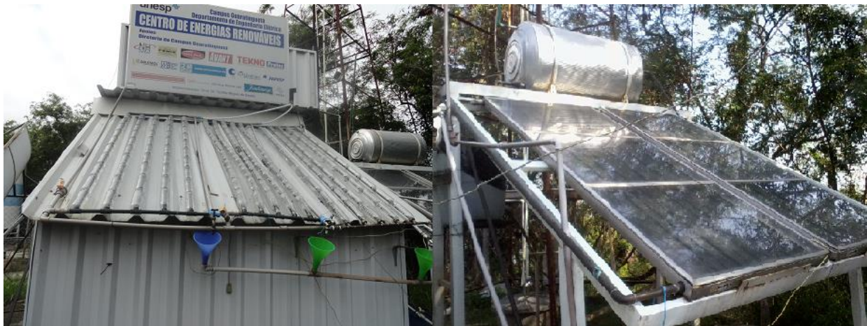
FIGURA 1 – Aquecedores Solares Feitos com Garrafas PET de 0,5L com Condutores de Alumínio, PVC e Cobre e Aquecedor Solar Industrial (5).
