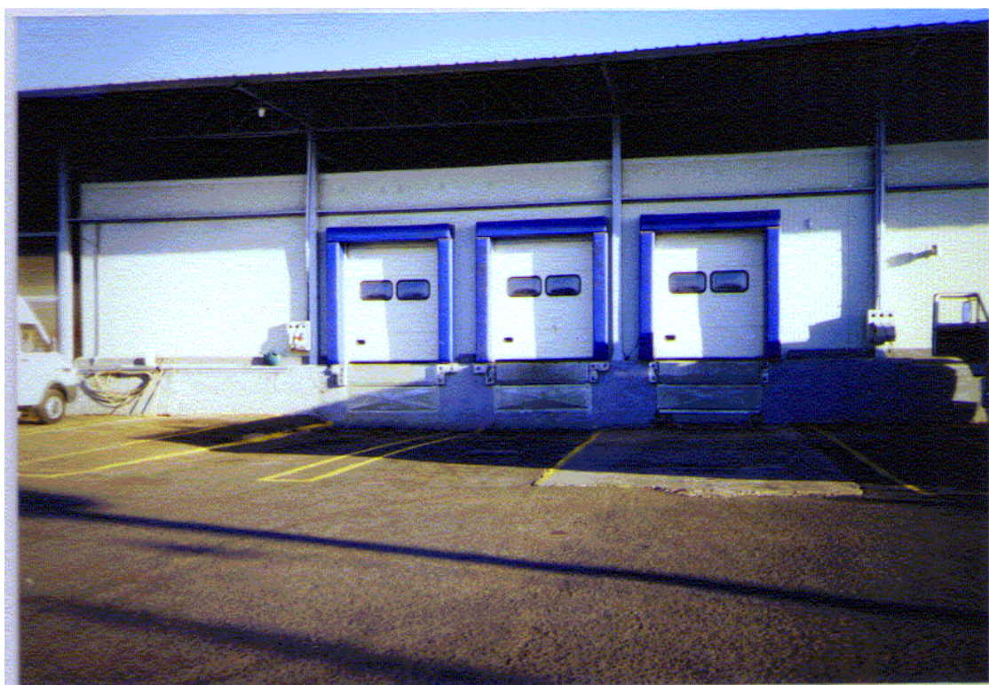
Figura 26 – Vista exterior da antecâmara
