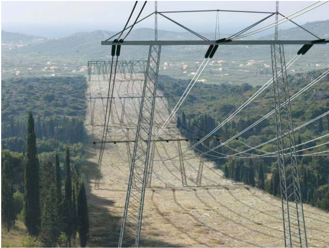
FIGURA 4 - Linha de transmissão e faixa de servidão 3
