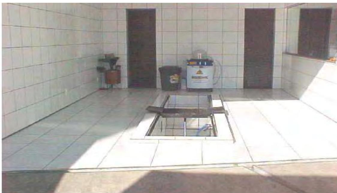
Figura 13: Box para Troca de Óleo dos Veículos e Canas de Drenagem
