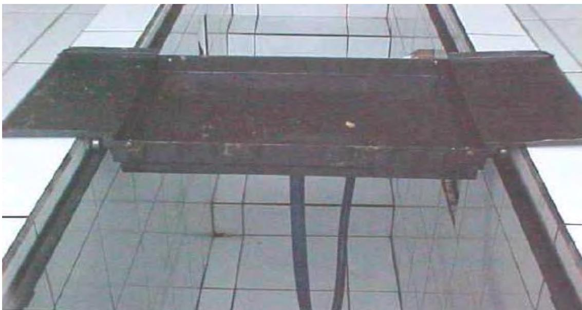
Figura 14: Bandeja Coletora de Óleo e Canalização que é Ligada a um Tanque Subterrâneo de Armazenagem
