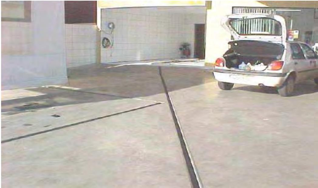
Figura 15: Pisos Impermeáveis e Calhas de Drenagem Instalados de Forma a Conduzir Águas do Pátio e Possíveis Vazamentos aos Sistemas de Tratamento
