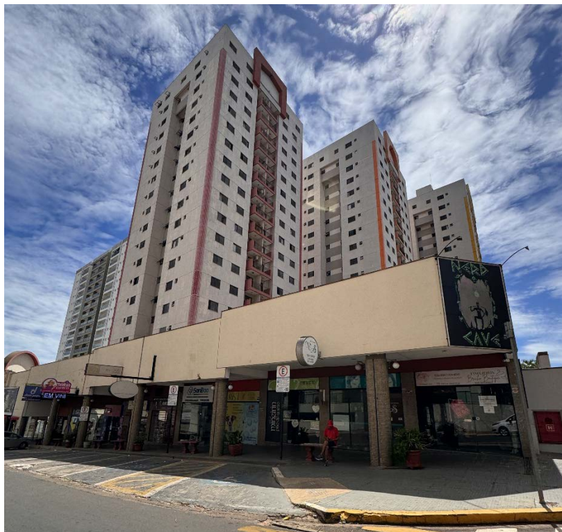
Figura 8 – Fachada ativa em condomínios verticais em Bauru. Fonte: Acervo da autora (2025).
